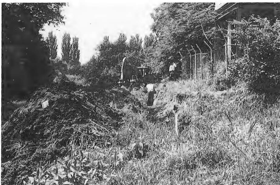
工学部先端電磁流体実験施設建設予定地
