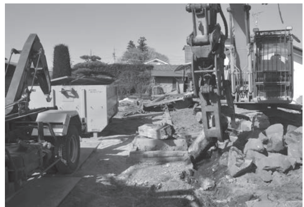
建物解体状況
