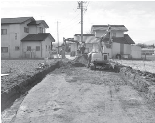
工事掘削状況
