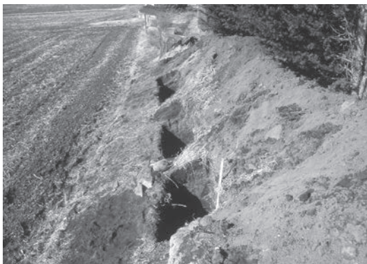
トレンチ掘削状況
