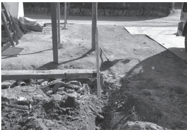
基礎撤去状況
