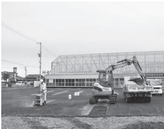
アスファルト除去状況
