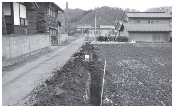
掘削状況（北側）
