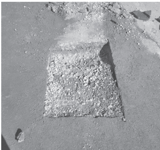
アスファルト除去状況
