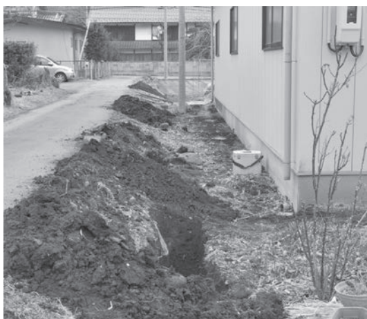
掘削状況（南側）
