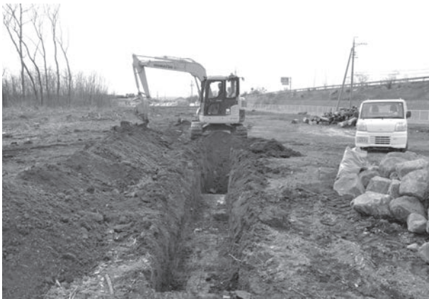
トレンチ掘削状況
