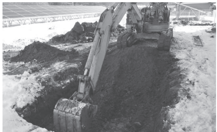
トレンチ掘削状況
