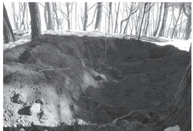
トレンチ掘削状況
