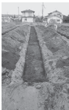
トレンチ掘削状況
