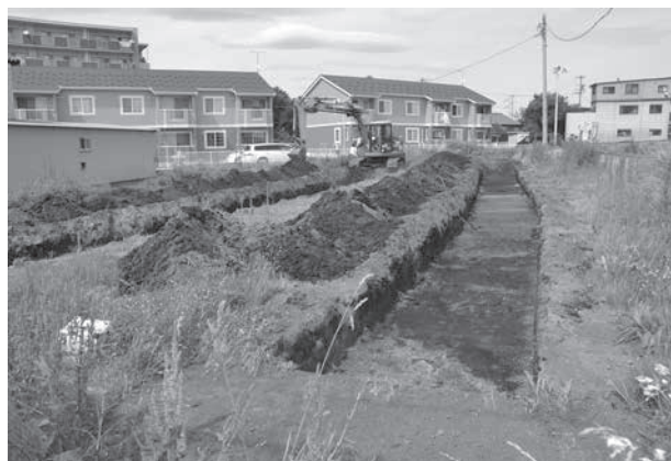
トレンチ掘削状況
