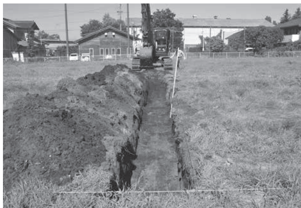
トレンチ掘削状況
