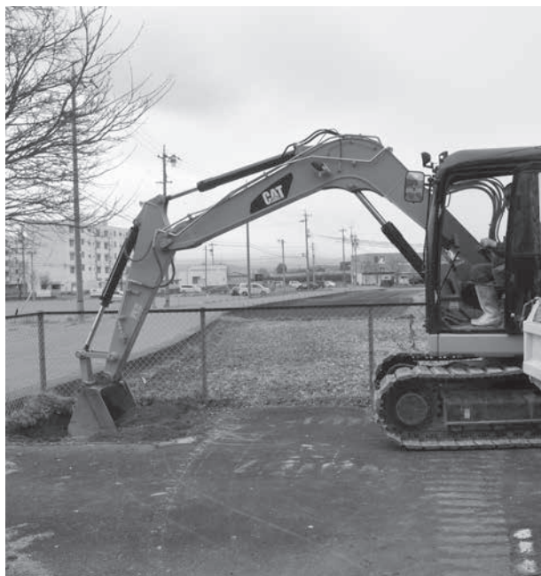
トレンチ掘削状況
