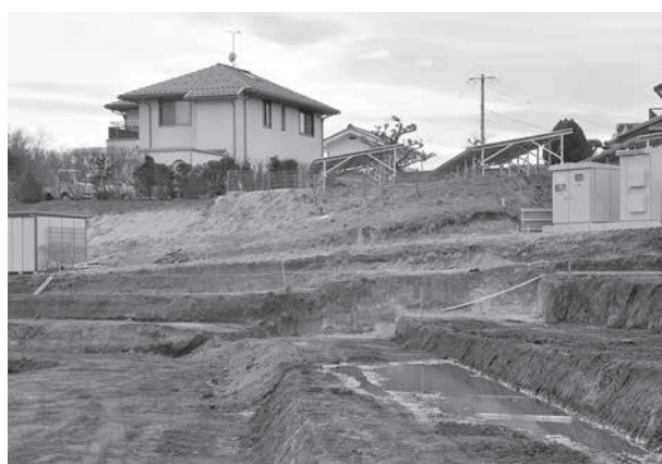
北側斜面地掘削状況
