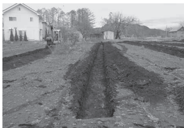
トレンチ掘削状況
