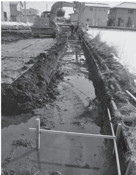
トレンチ掘削状況
