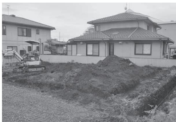
トレンチ掘削状況
