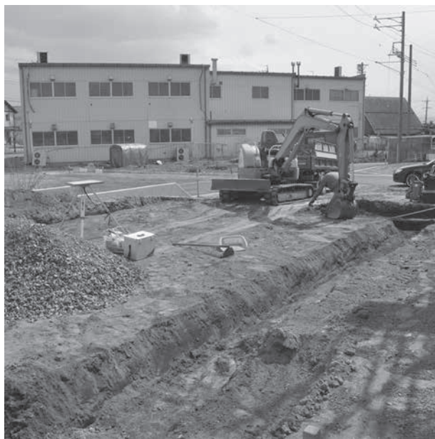
トレンチ掘削状況
