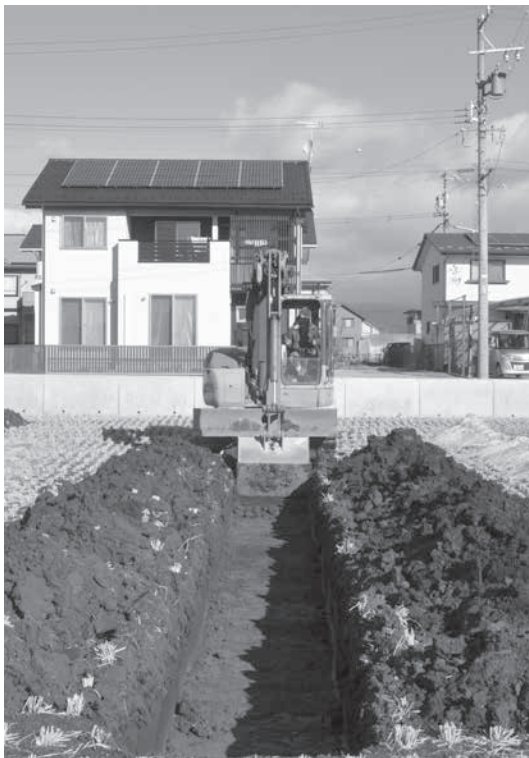
トレンチ掘削状況
