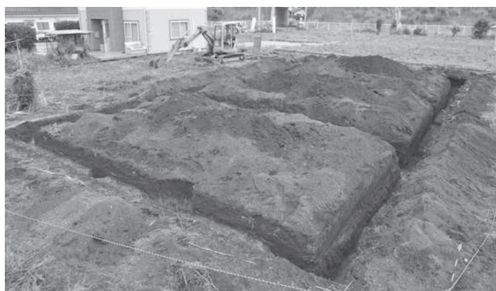
トレンチ掘削状況
