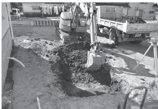
浄化槽設置箇所掘削状況
