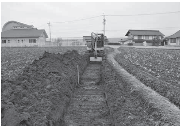
トレンチ掘削状況
