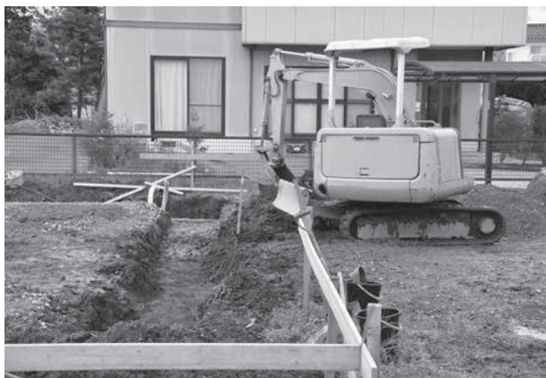
トレンチ掘削状況
