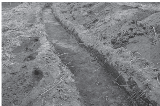
トレンチ掘削状況
