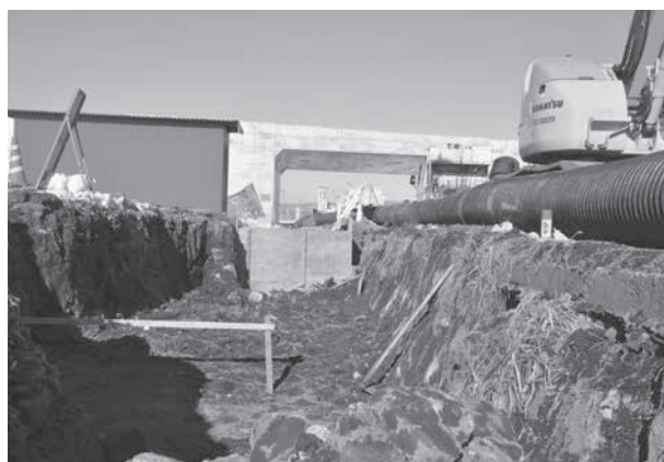
トレンチ掘削状況
