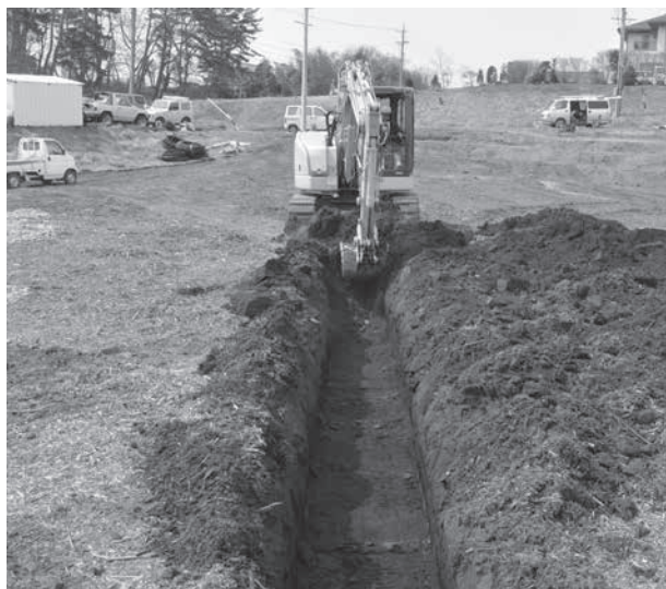
トレンチ掘削状況
