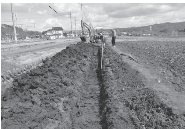
低地トレンチ掘削状況
