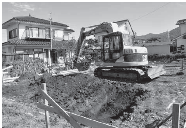
トレンチ掘削状況
