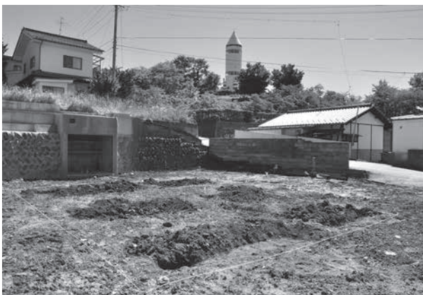
トレンチ掘削状況
