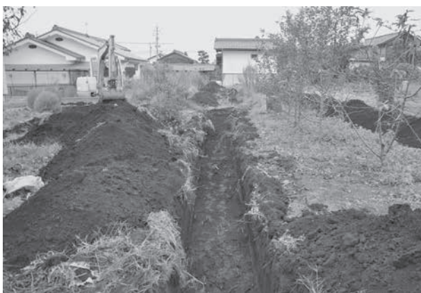
トレンチ掘削状況
