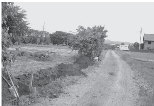
トレンチ掘削状況
