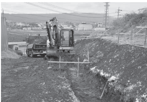
トレンチ掘削状況
