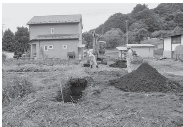
トレンチ掘削状況
