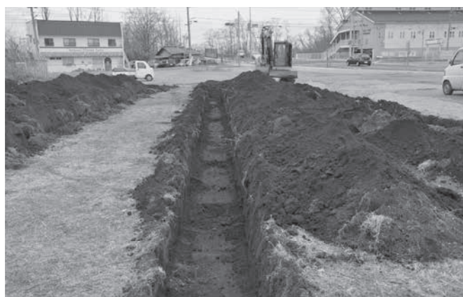
トレンチ掘削状況
