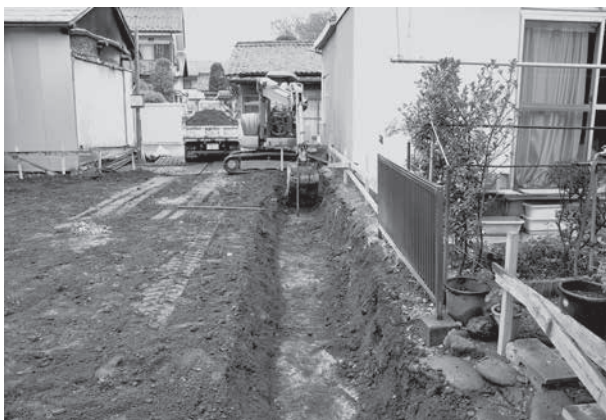
トレンチ掘削状況
