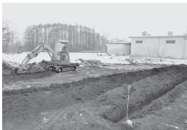
トレンチ掘削状況
