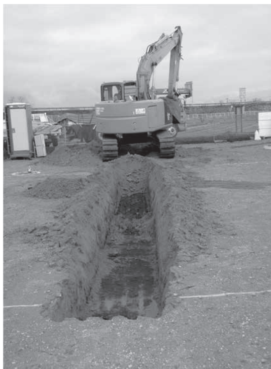
トレンチ掘削状況
