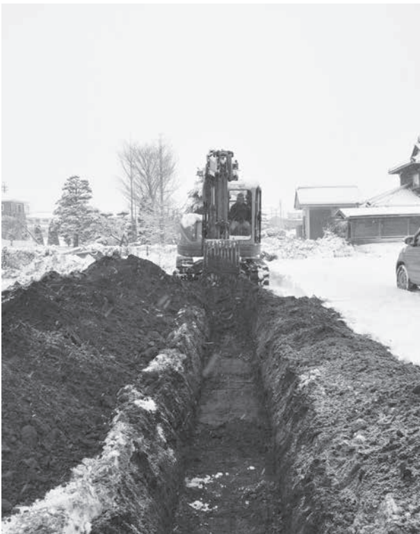
トレンチ掘削状況
