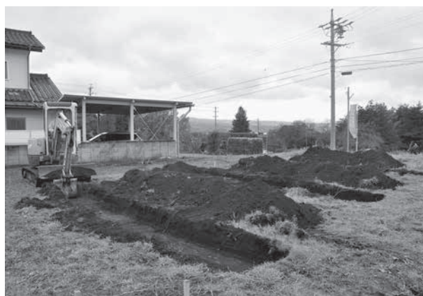
トレンチ掘削状況
