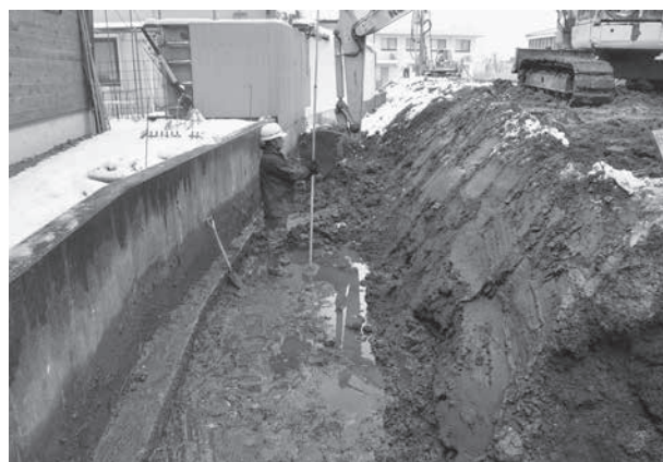
トレンチ掘削状況
