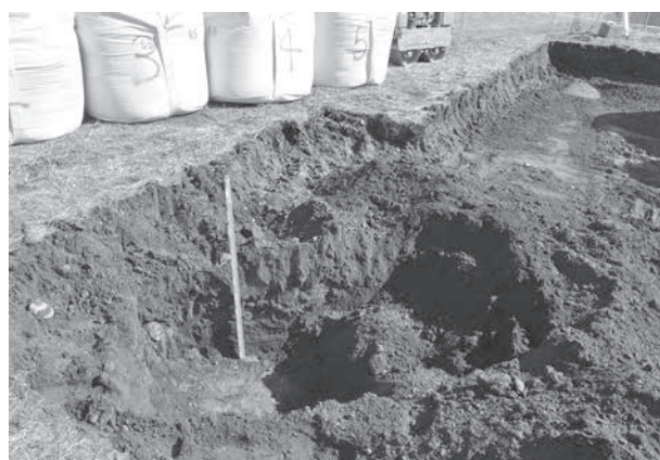
トレンチ掘削状況
