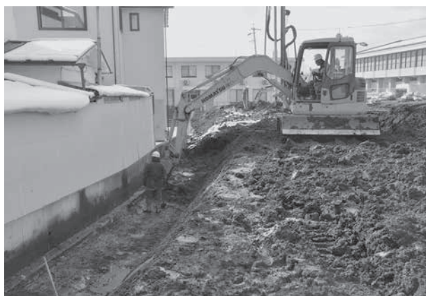
トレンチ掘削状況
