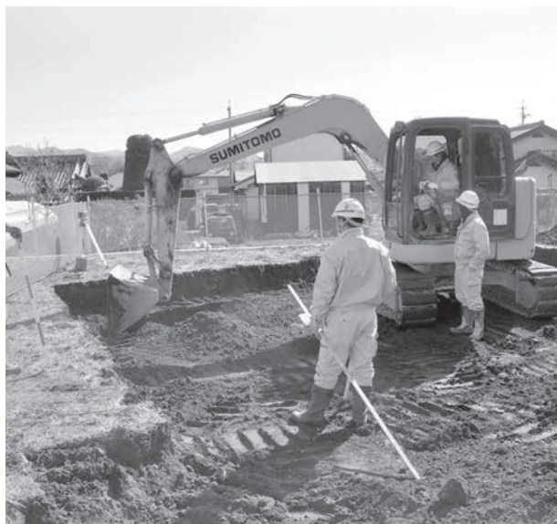
トレンチ掘削状況
