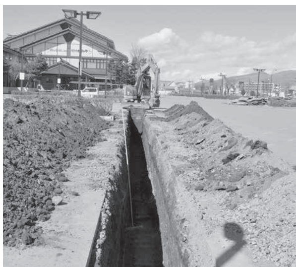
トレンチ掘削状況
