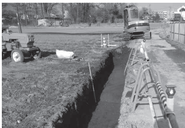
トレンチ掘削状況
