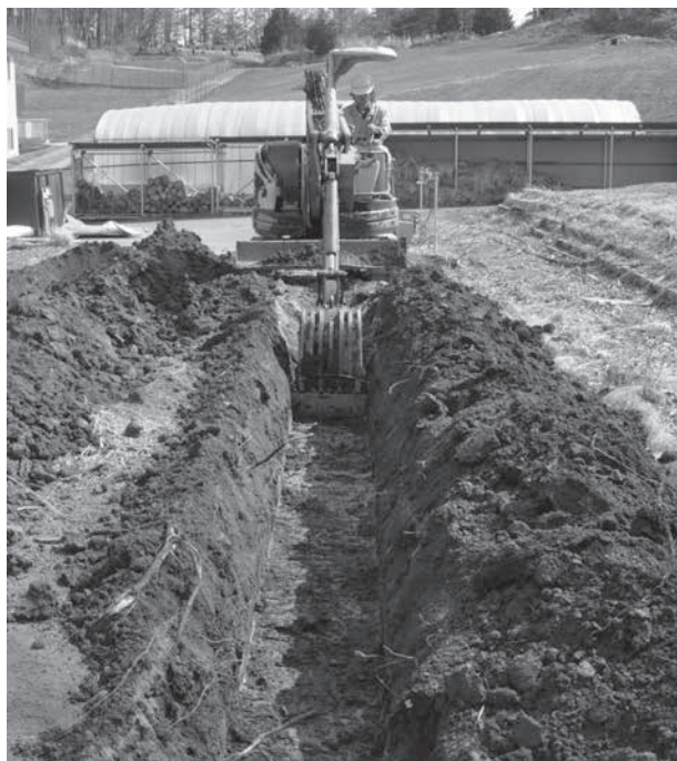
トレンチ掘削状況
