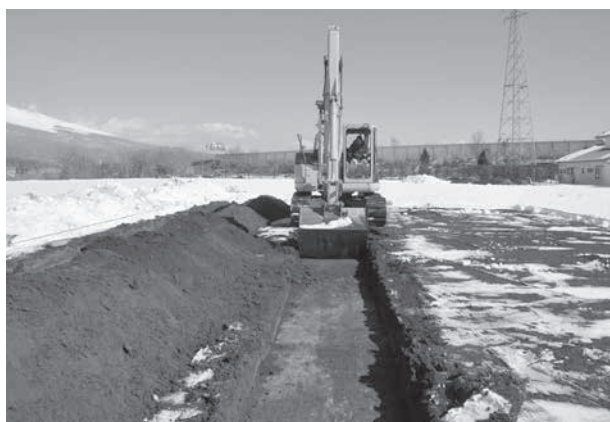
トレンチ掘削状況
