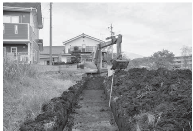
トレンチ掘削状況
