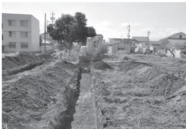
トレンチ掘削状況
