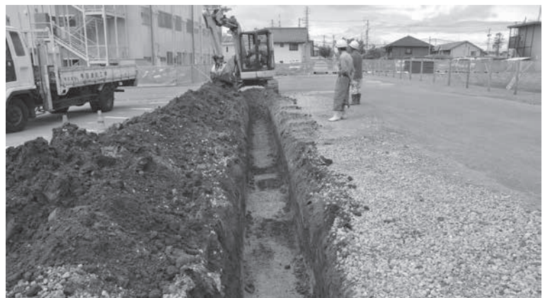
トレンチ掘削状況
