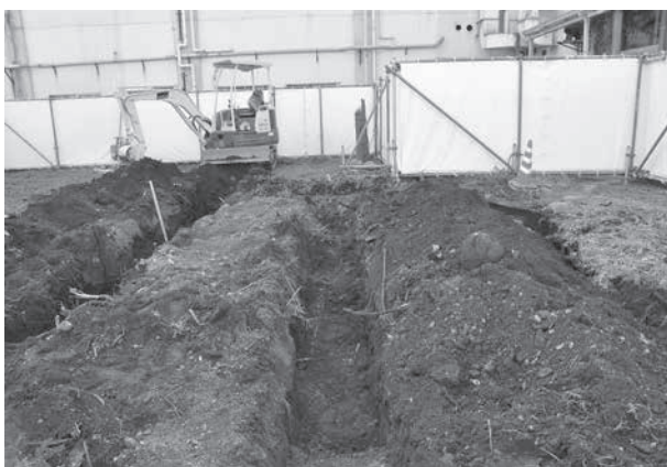
トレンチ掘削状況
