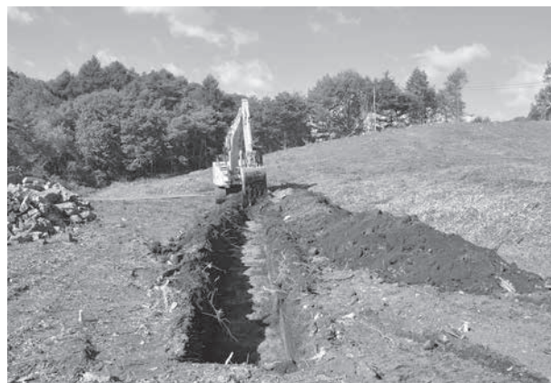
トレンチ掘削状況
