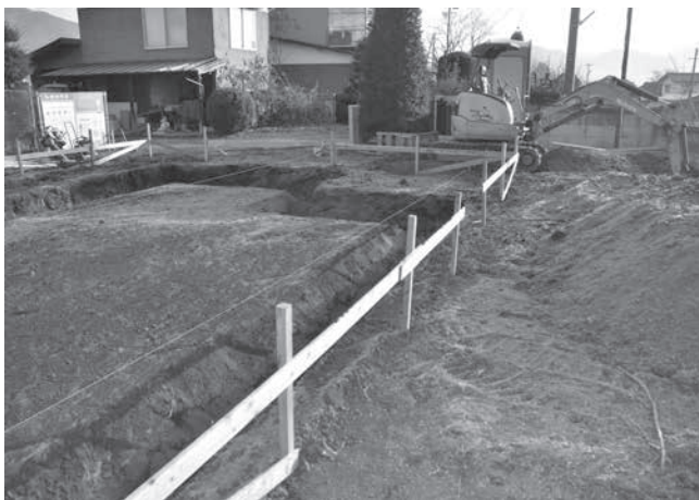
トレンチ掘削状況
