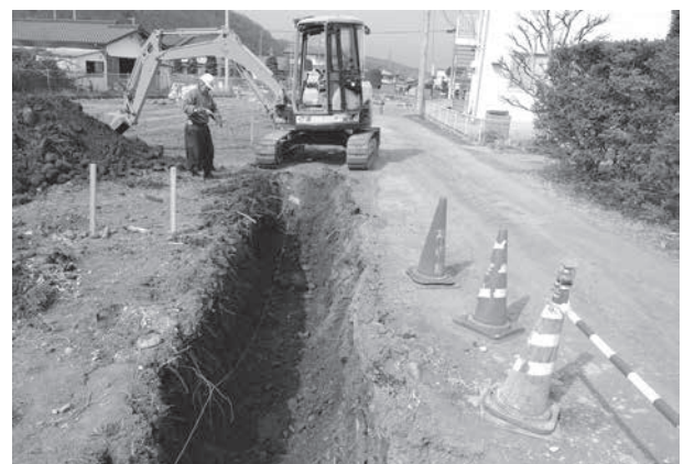
トレンチ掘削状況
