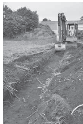
トレンチ埋め戻し状況
