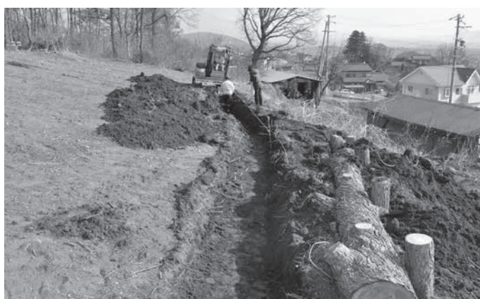
トレンチ掘削状況
