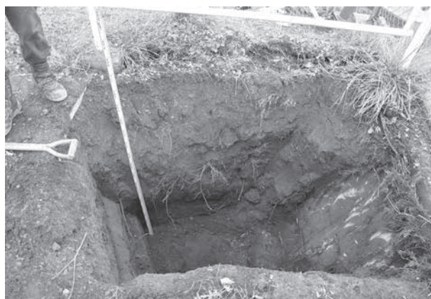
トレンチ掘削状況
