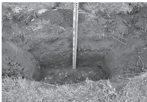
トレンチ掘削状況・土層堆積状況
