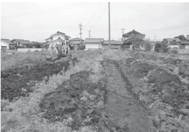
トレンチ掘削状況
