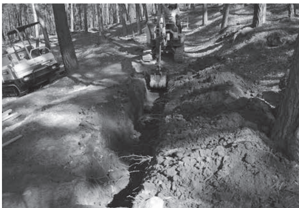
トレンチ掘削状況
