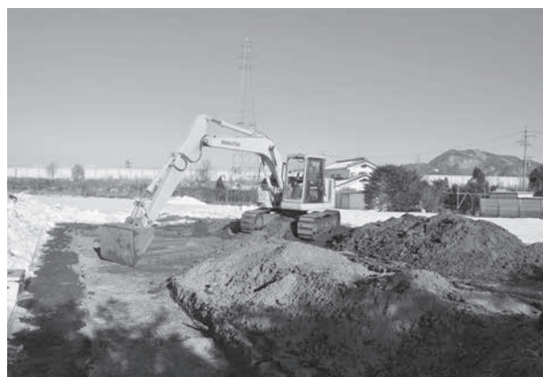
トレンチ拡張状況
