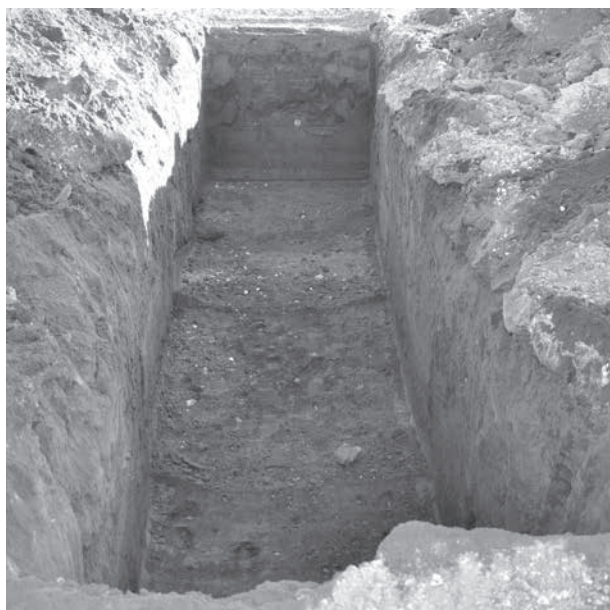
トレンチ掘削状況
