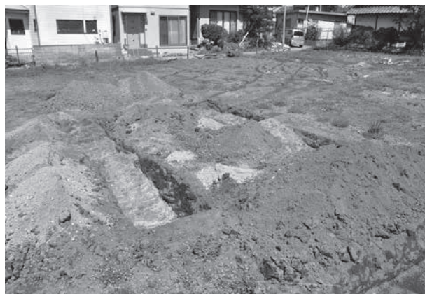
トレンチ掘削状況
