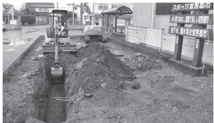
トレンチ掘削状況
