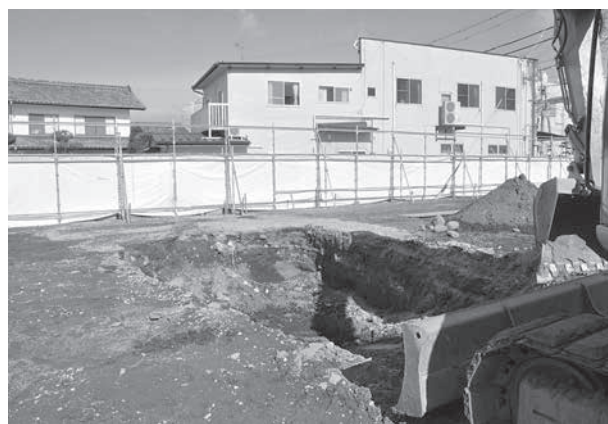
トレンチ掘削状況
