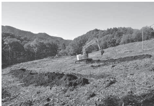
トレンチ掘削状況
