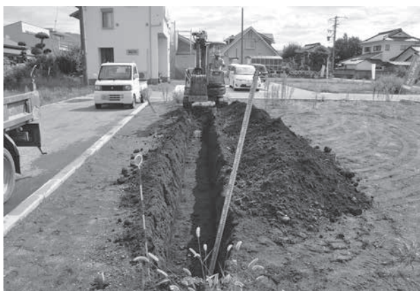
トレンチ掘削状況
