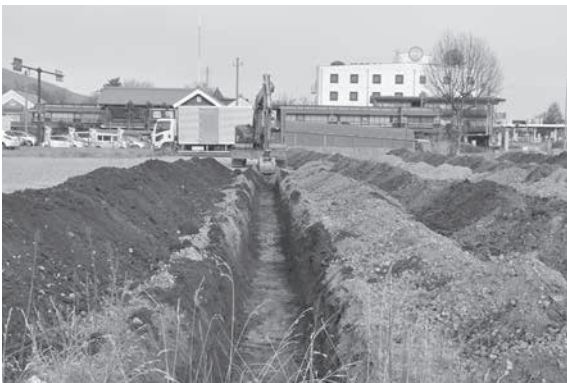
トレンチ掘削状況
