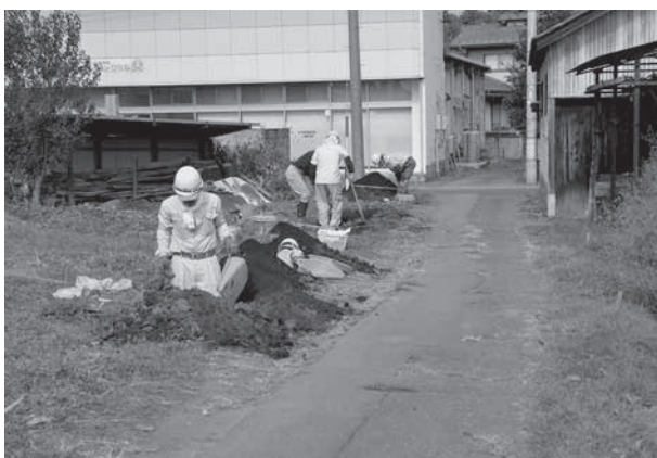
トレンチ掘削状況
