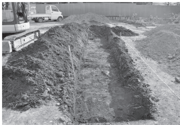
トレンチ掘削状況
