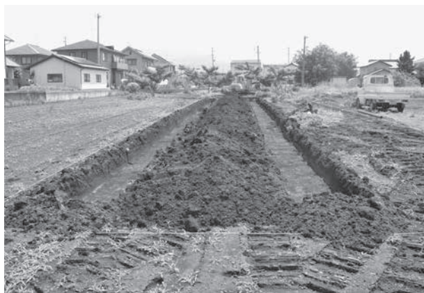
トレンチ掘削状況
