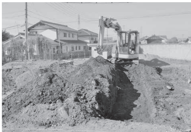
トレンチ掘削状況
