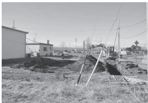
トレンチ掘削状況
