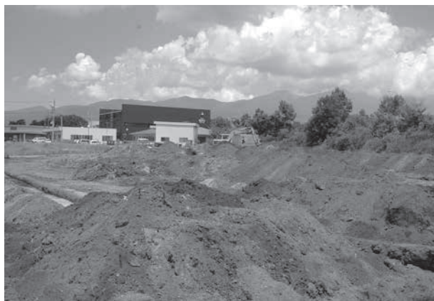
トレンチ掘削状況
