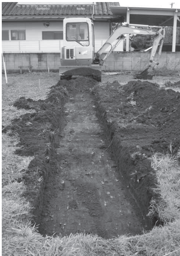
トレンチ掘削状況
