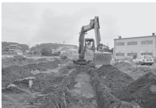
トレンチ掘削状況
