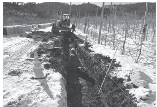
トレンチ掘削状況
