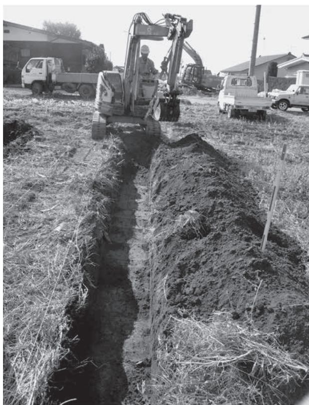
トレンチ掘削状況
