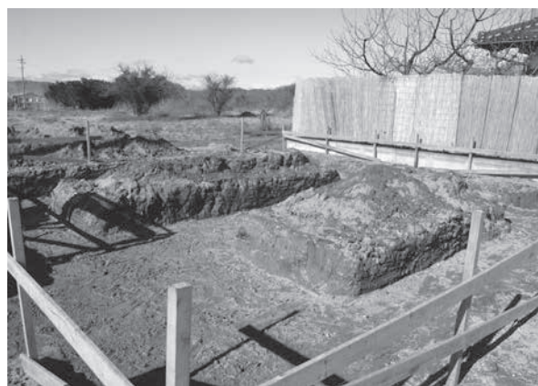
トレンチ掘削状況
