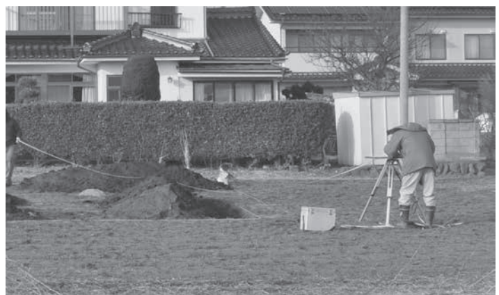
トレンチ掘削状況
