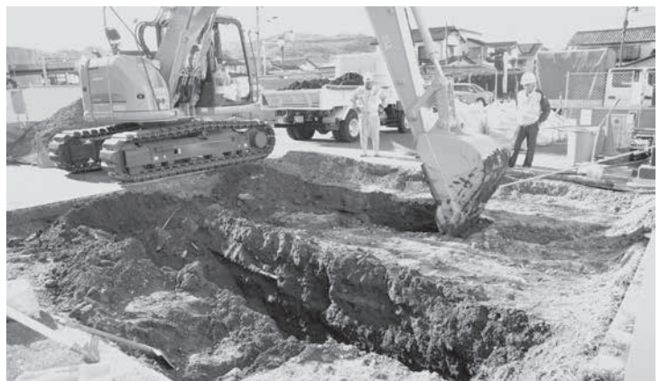
トレンチ掘削状況
