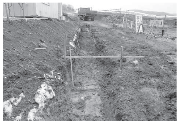
トレンチ掘削状況
