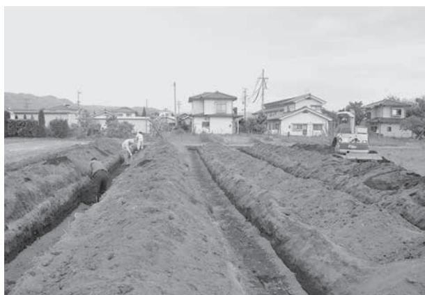
トレンチ掘削状況
