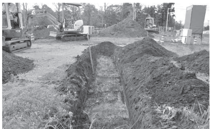
トレンチ掘削状況
