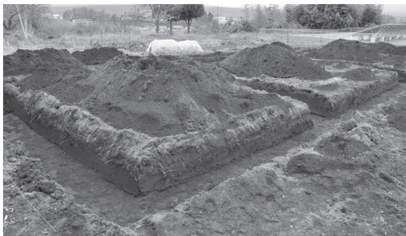
トレンチ掘削状況
