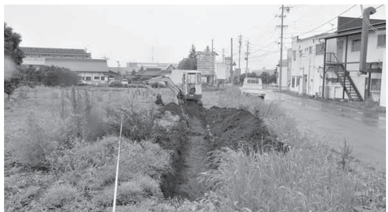
トレンチ掘削状況
