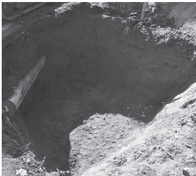
排水枡掘削状況
