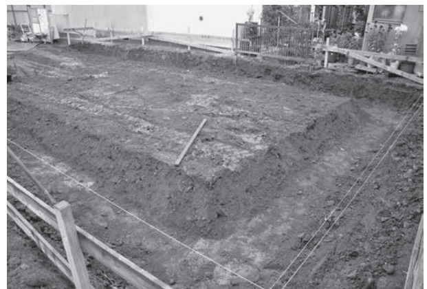
トレンチ掘削状況
