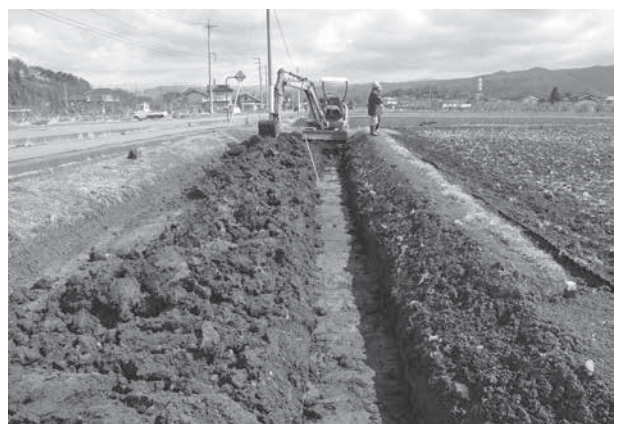
トレンチ掘削状況
