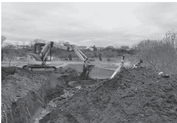
トレンチ掘削状況
