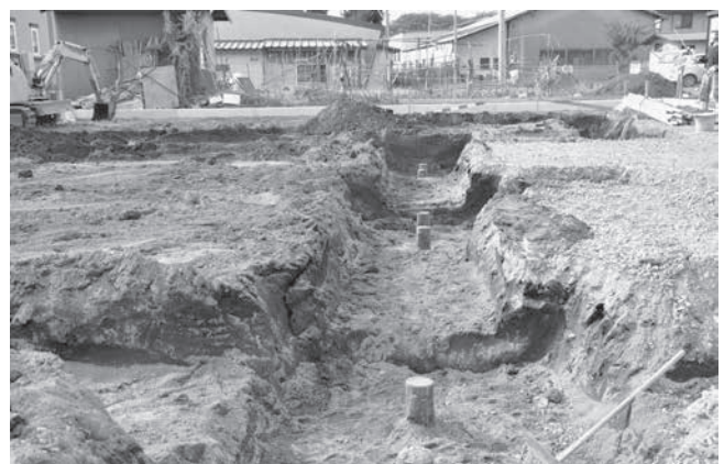
トレンチ掘削状況
