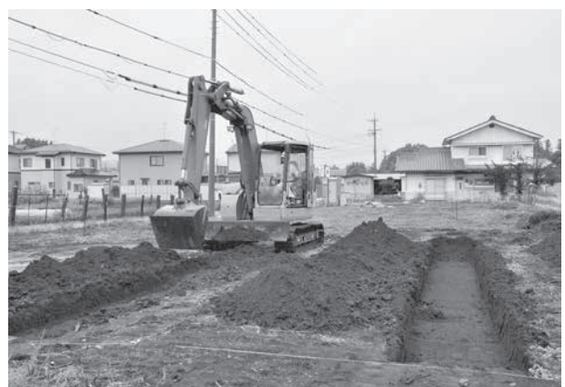
トレンチ掘削状況
