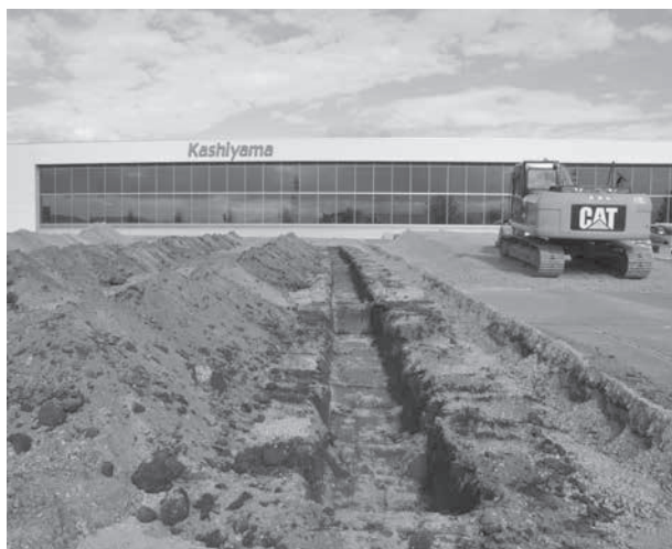
トレンチ掘削状況
