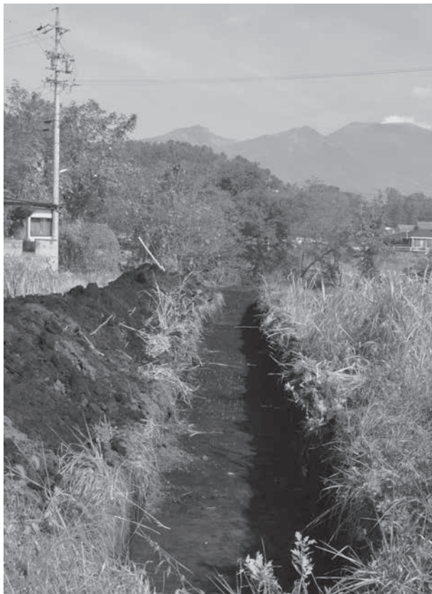
トレンチ掘削状況
