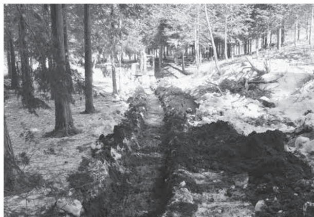
トレンチ掘削状況
