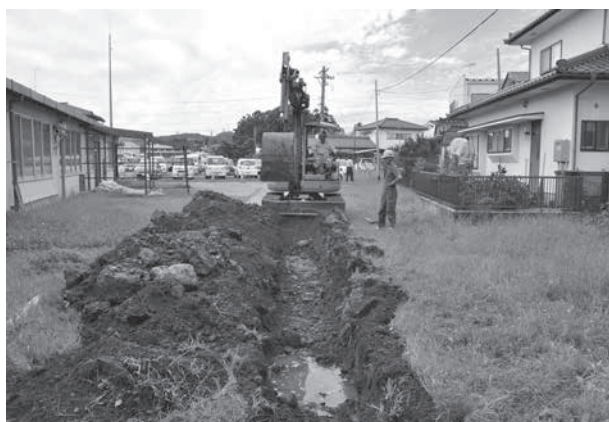
トレンチ掘削状況
