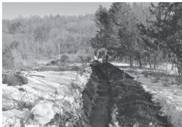
トレンチ掘削状況
