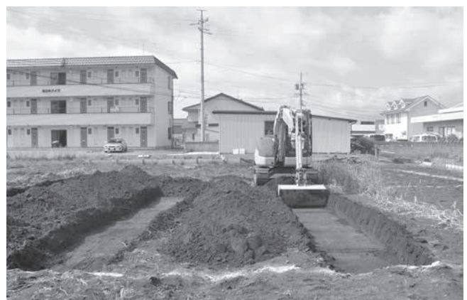
トレンチ掘削状況
