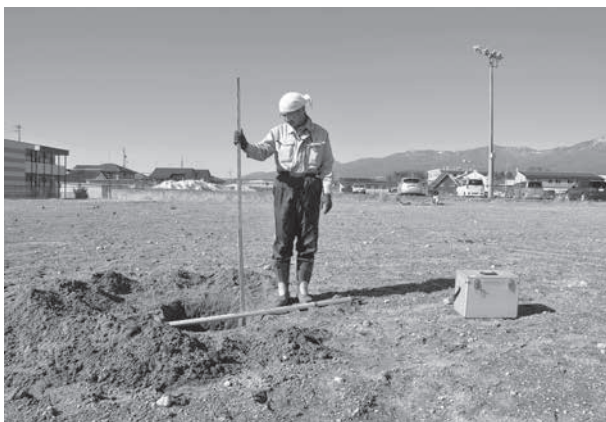
トレンチ掘削状況
