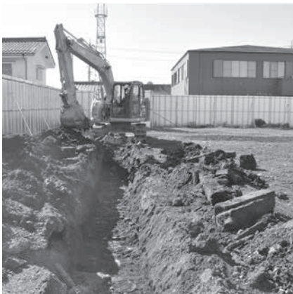
トレンチ掘削状況
