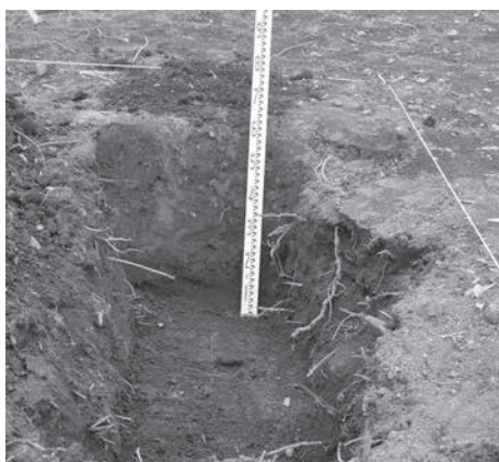
トレンチ掘削状況
