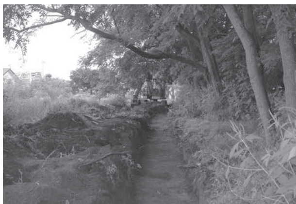
トレンチ掘削状況
