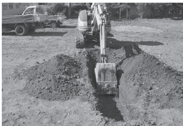
トレンチ掘削状況
