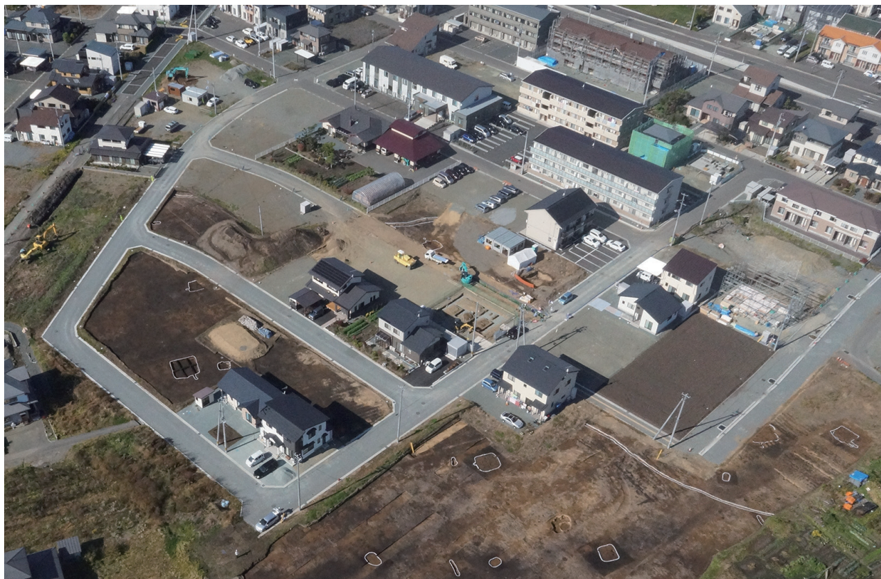
Ⅱ 西区・Ⅲ区全景 (南東から)
