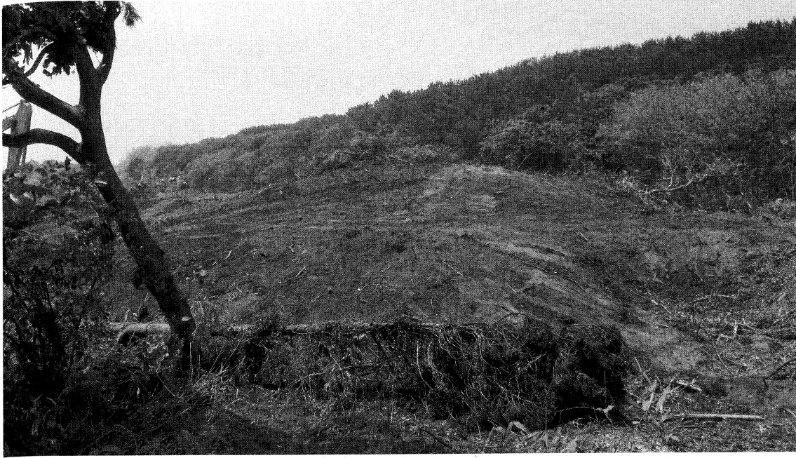
調査区北側掘削前 <平成20年度> (東から)
