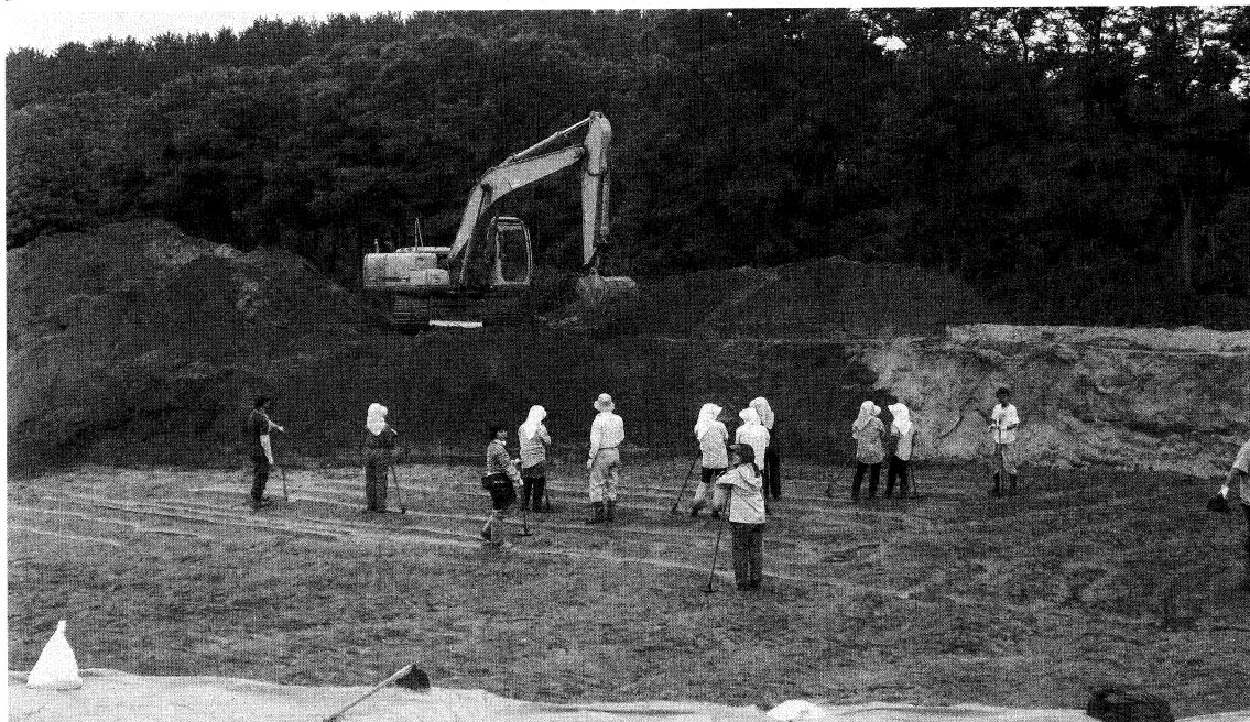
砂丘砂掘削状況 <平成20年度> (南から)
