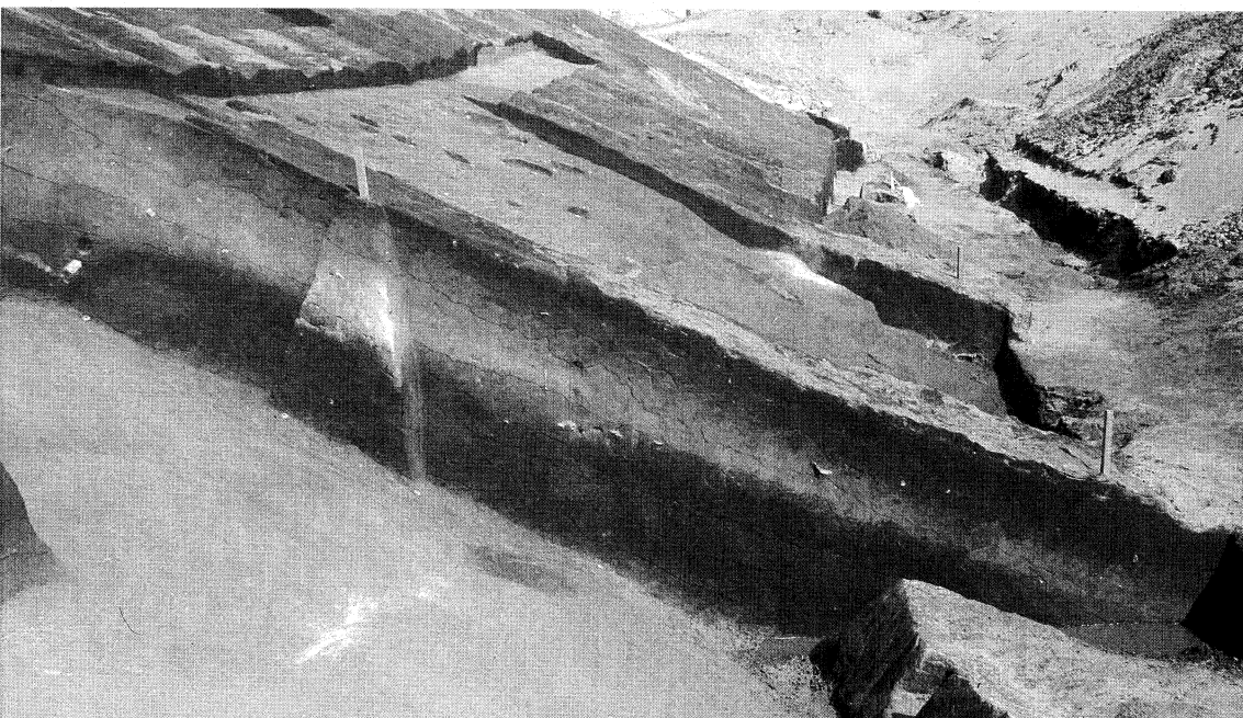
F35グリッド付近盛土 土層断面(南から)
