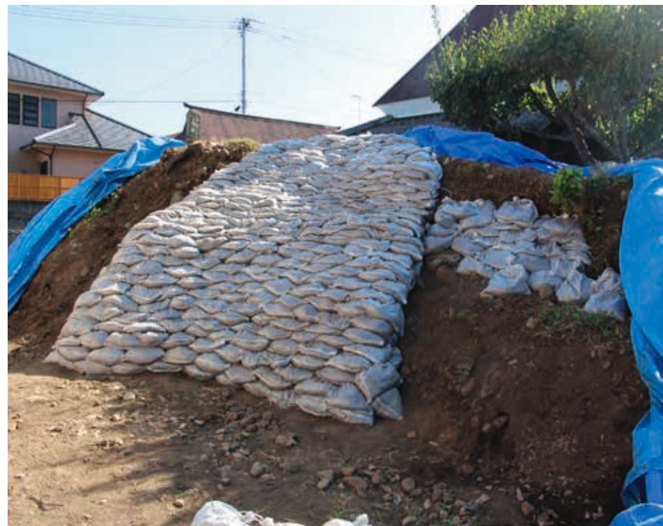
写真17 相原廃寺土のう保護状況
