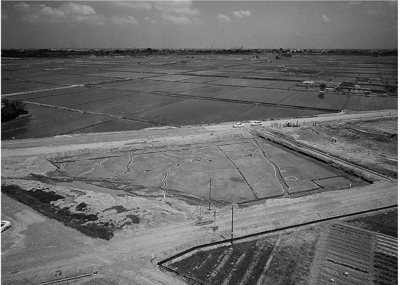
C地点遠景 (平成4年度 東から)
