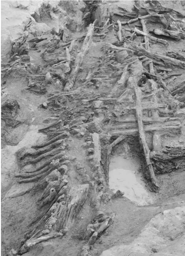
写17 SD 1井堰西半部（西から）
