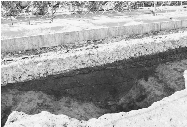
S K256土層断面 (東から)
