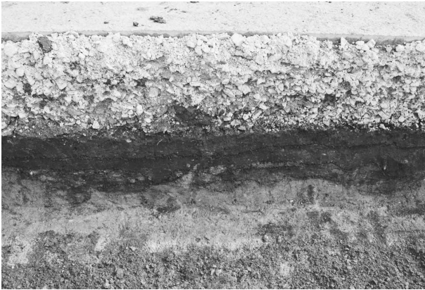
SH9 西部土層断面 (北西から)
