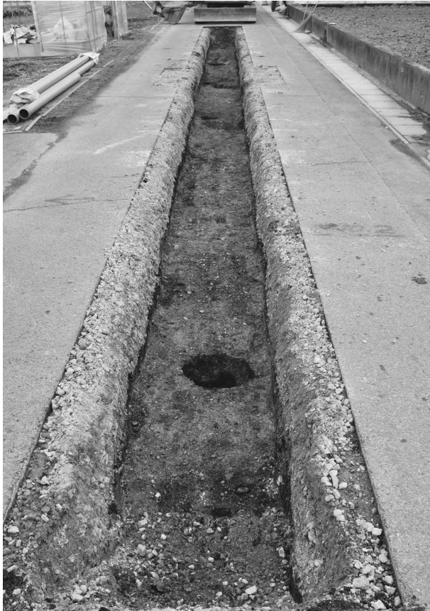
調査区4SA33付近遺構掘削状況（北東から）
