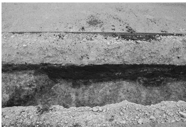
S K41西側肩部 (南東から)
