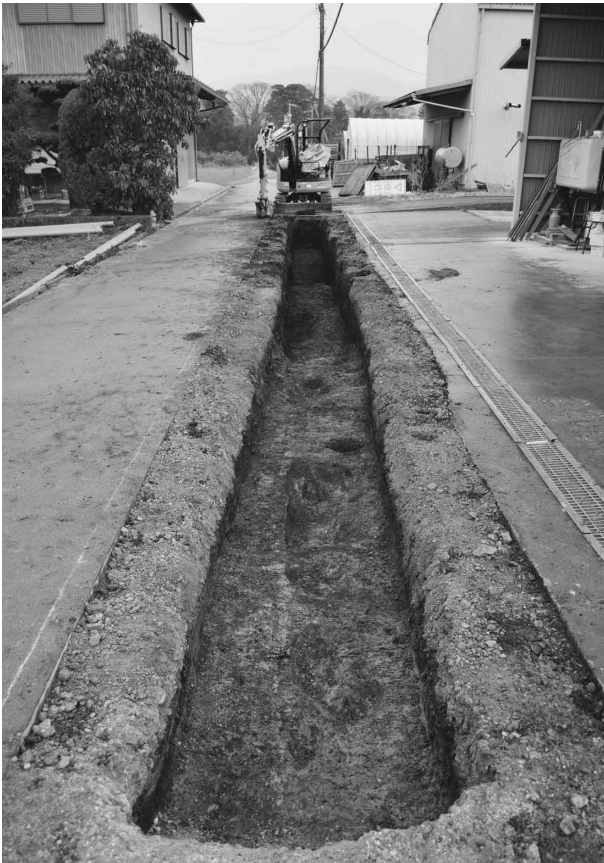
調査区 7-④西部遺構掘削状況 (北西から)
