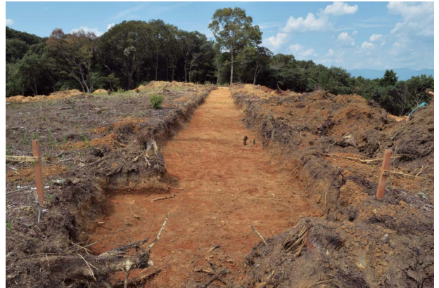
写24 第1次 T-5区 (東から)
