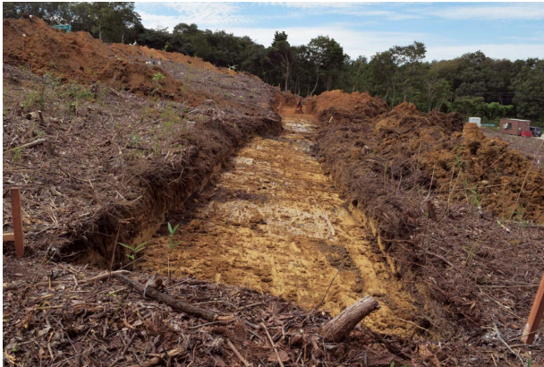
写23 第1次 T-3区 (東から)
