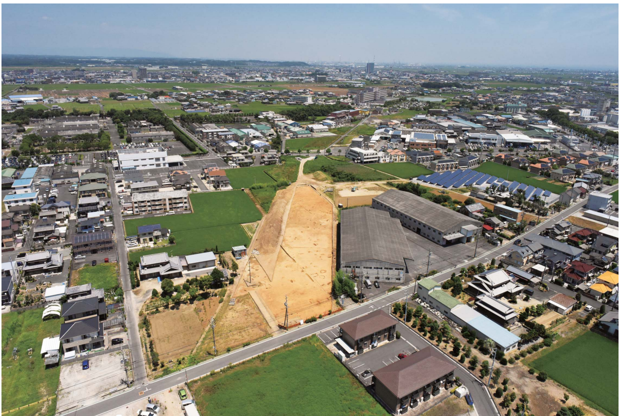
写6 石垣遺跡第3次調査区全景（南上空から）
