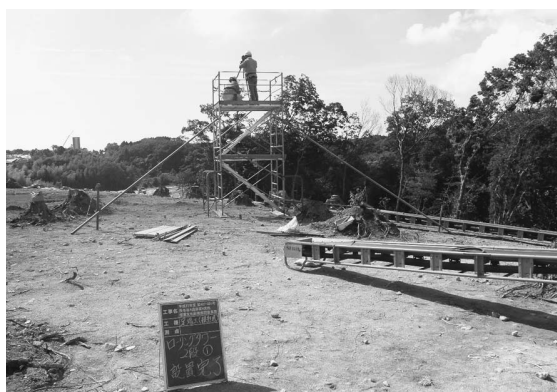
写11 写真撮影（ローリングタワー）
