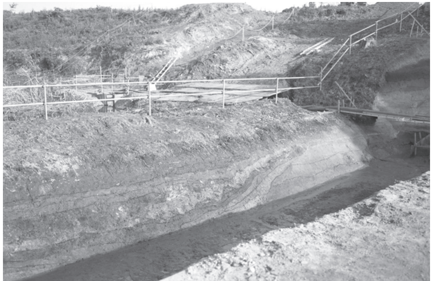
土層断面 Aライン運河部(南西から)
