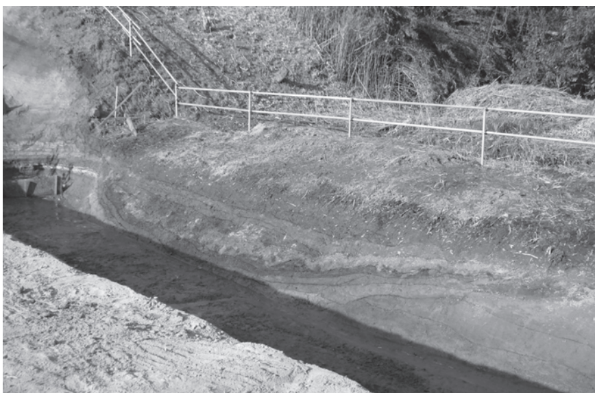
土 層 断 面 Aライン運河部(南東から)
