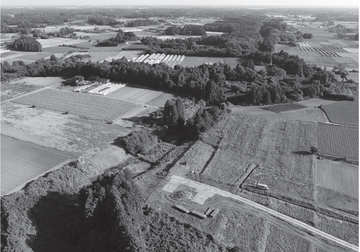
調査前現況遠景（南東から）
