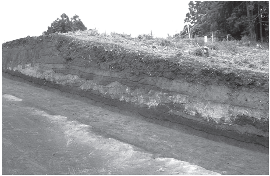
土 層 断 面 C ラ イ ン 東 斜 面 部
