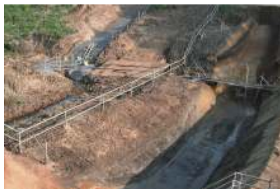
運河跡に堆積した土砂の様子
