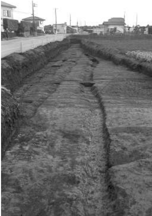
第1号道路跡 側溝 1～4 完掘状況
