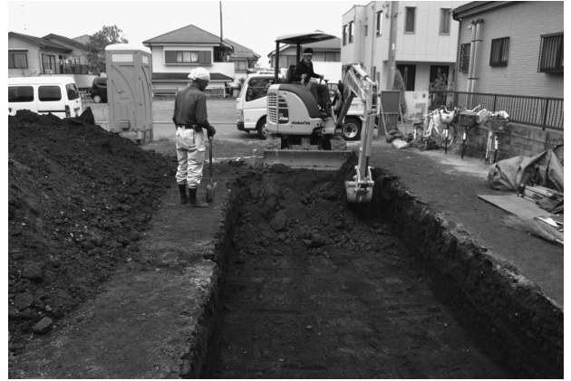
苗間東久保遺跡第 33 地点トレンチ 6 本調査風景
