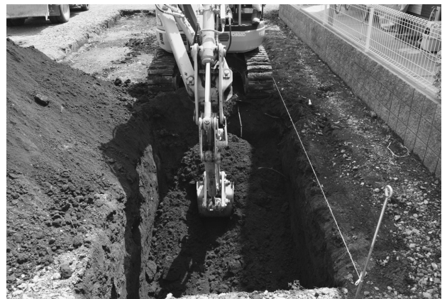
大井宿遺跡第 17 地点調査風景
