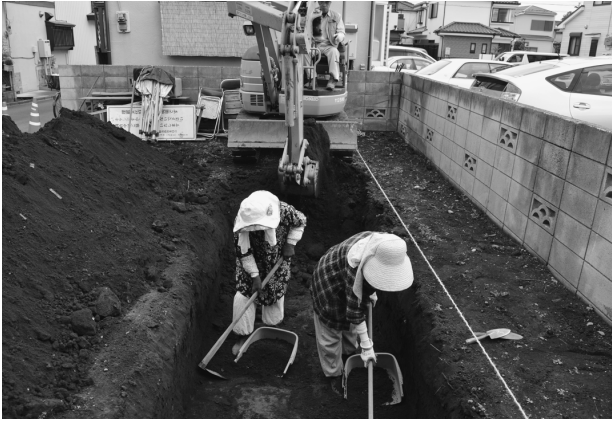
浄禅寺跡遺跡第 38 地点調査風景
