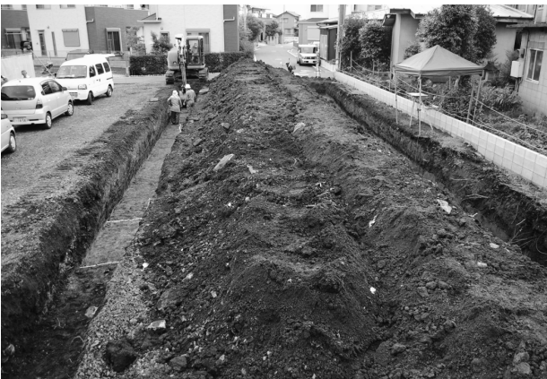
長宮遺跡第 46 地点近景
