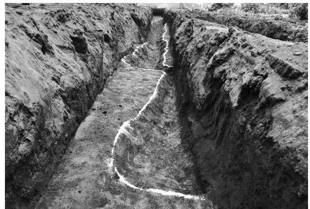
長宮遺跡第45地点トレンチ3
