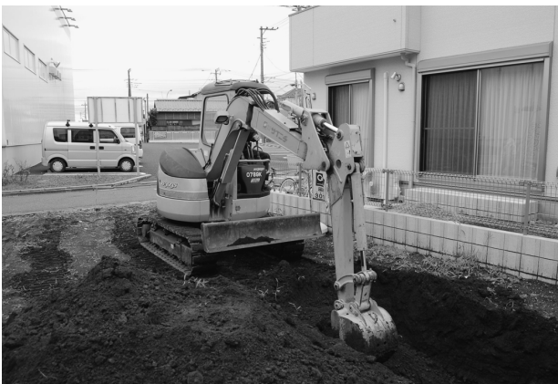
江川南遺跡第 26 地点調査風景
