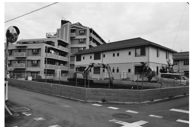
長宮遺跡第 47 地点近景
