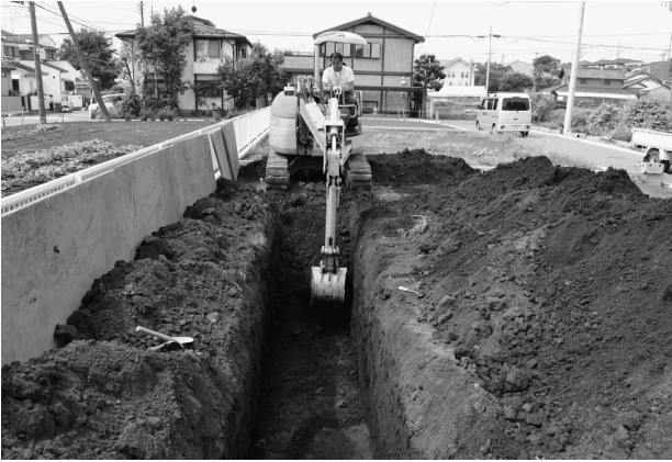
滝遺跡第 22 地点調査風景
