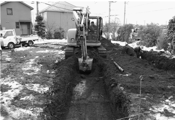
滝遺跡第 23 地点調査風景
