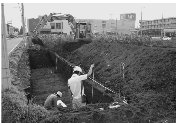
東中学校西遺跡第 33 地点調査風景
