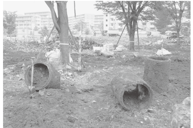
ヒューム管（D区）
