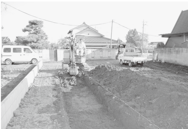
滝遺跡第 16 地点調査風景
