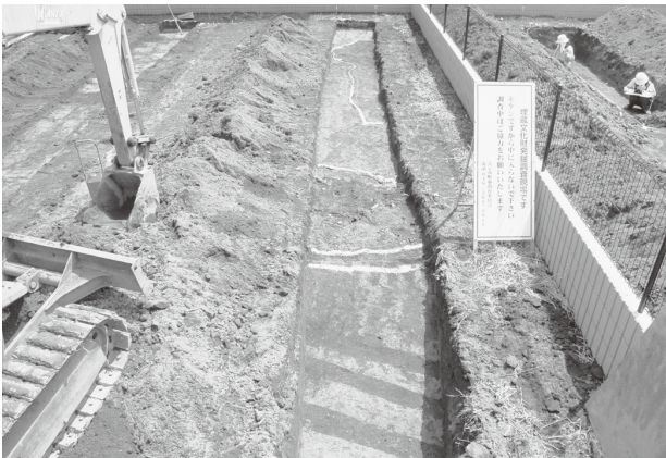
本村遺跡第 121 地点トレンチ 5
