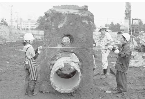
排水枡（F区）
