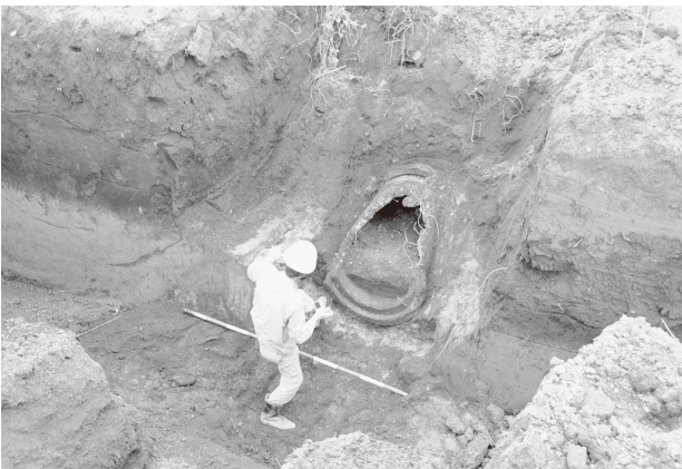
ヒューム管（M区）出土状況
