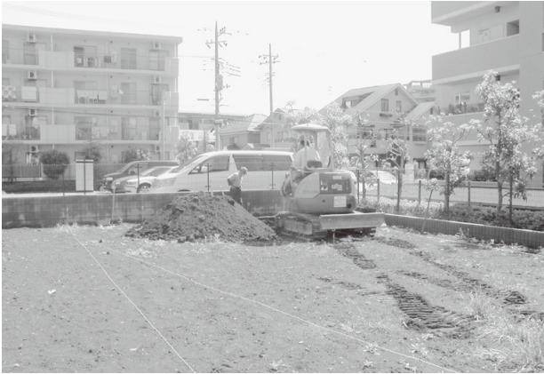
本村遺跡第 121 地点近景
