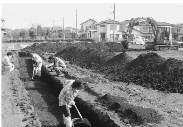
滝遺跡第12地点試掘調査
