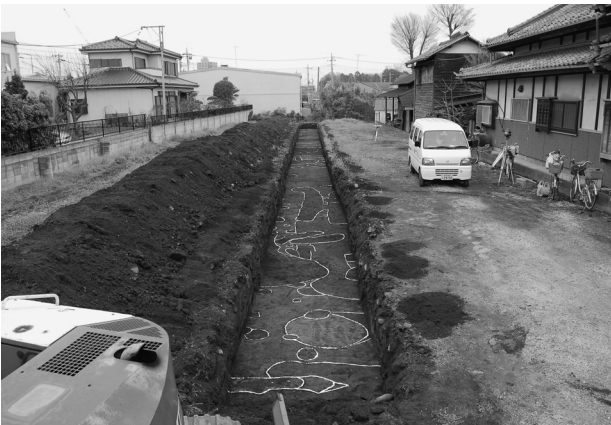
大井宿遺跡第14地点試掘調査
