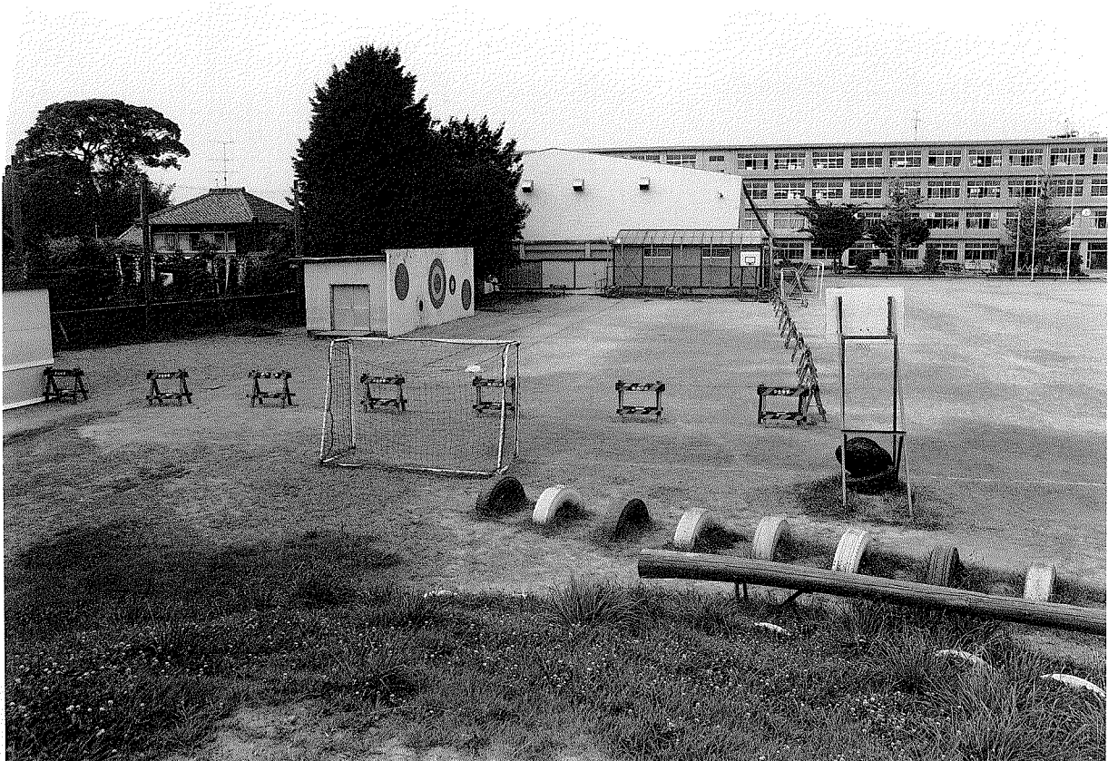
調査前全景 (南から)
