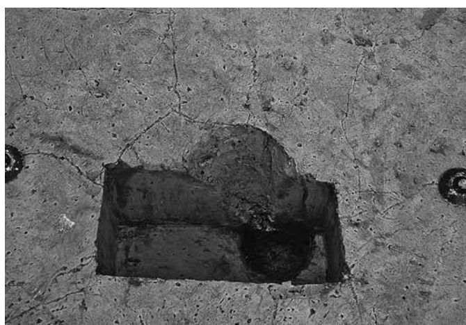
P88 完掘状況 東から
