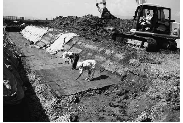
西地区調査風景 北から
