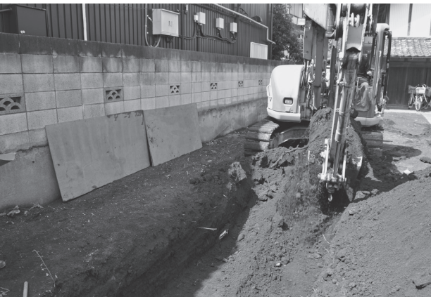
大井氏館跡遺跡第 24 地点調査風景
