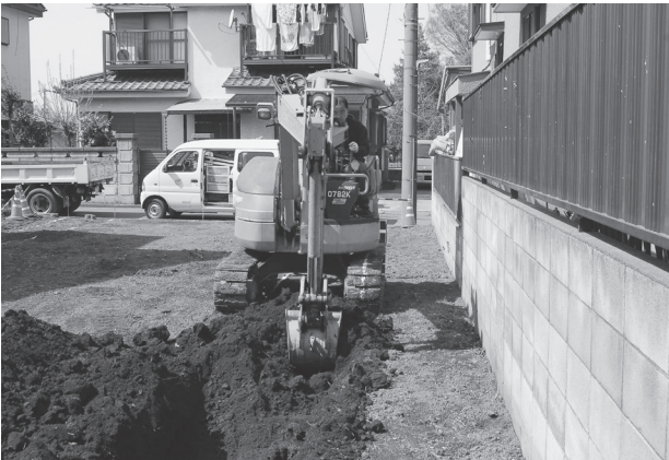
ハケ遺跡第 15 地点調査風景
