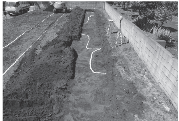
亀居遺跡第 73 地点トレンチ 1
