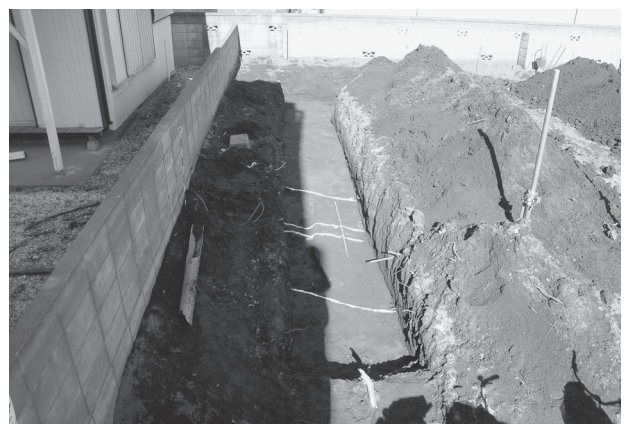
西ノ原遺跡第 163 地点トレンチ 1
