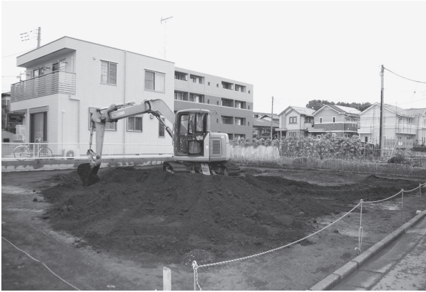
滝遺跡第 24 地点調査風景
