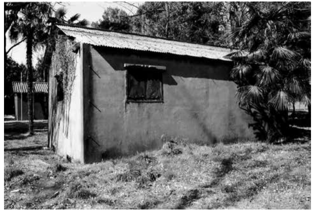
6 南側全景 屋根は波トタン板葺きとなる
