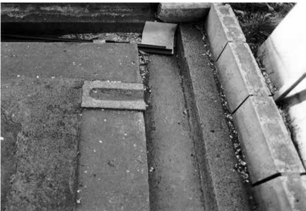
9 縦樋を伝って流れる雨水を受けた石製の受け皿
