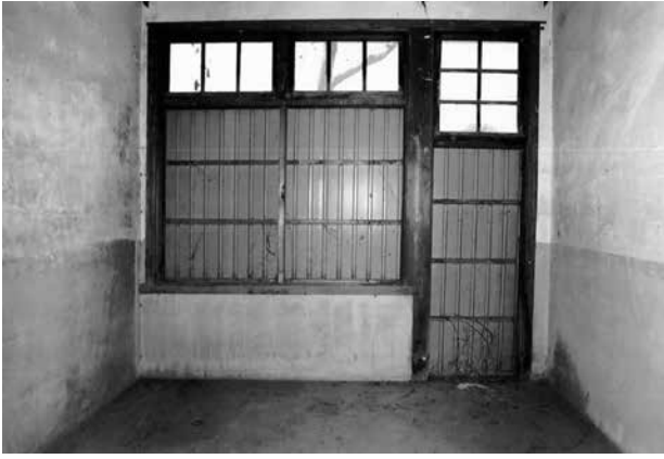
15 爆薬填実室の作業室窓側 各部屋に出入口がつく
