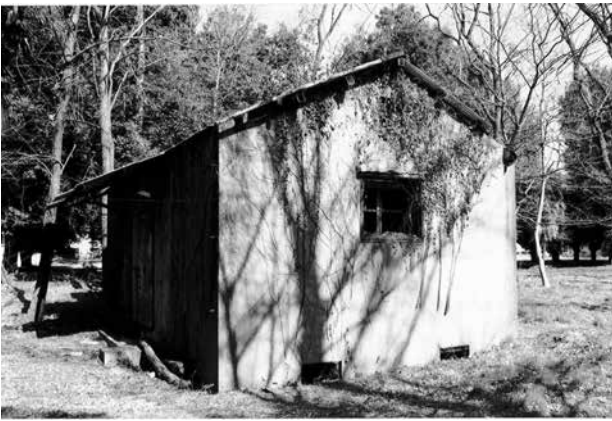
3 西側から見た火薬倉庫全景
