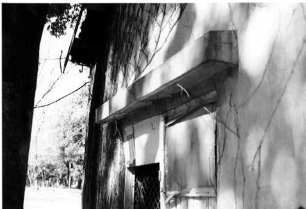
5 入口上部の庇状の突起
