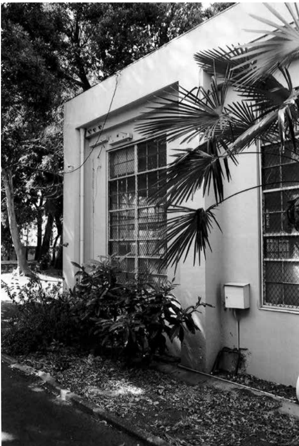
10 南東西側外壁の近景
