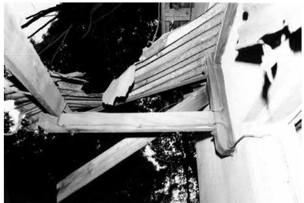
22 庇の持ち送り
