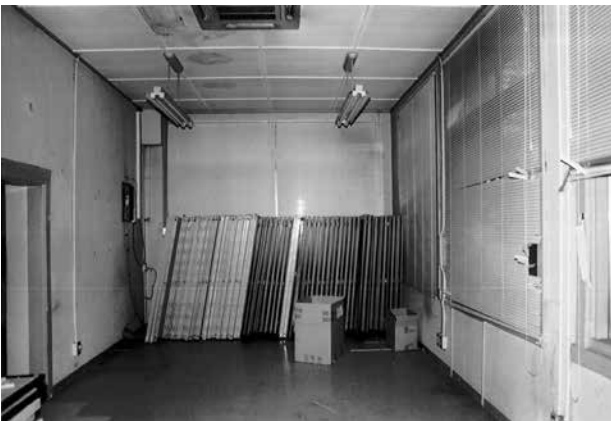
20 作業室内部 もっとも南側の部屋 右手は窓、左はコンクリート造の壁
