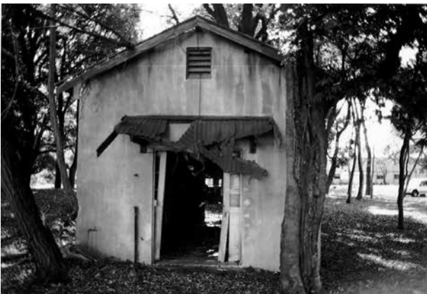
12 北東側妻面 波トタンの庇が付けられている
