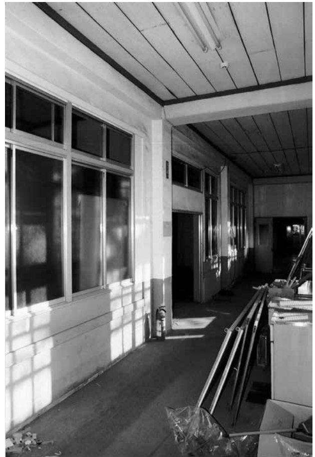
16 同左 廊下と作業室を仕切る壁 大きく改造されている
