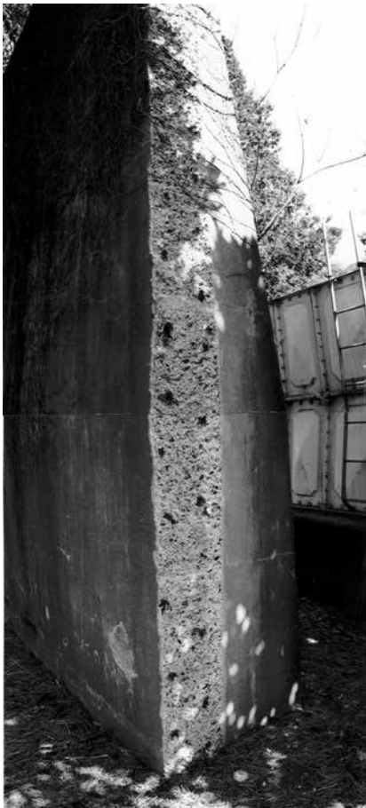
5 防爆壁の切断面
