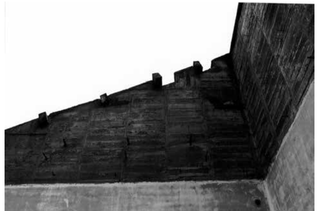
31 切断されたモヤ タルキを使わず じかに野地板が貼られていた
