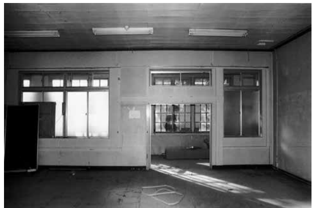
30 29 に続く部屋の廊下側間仕切り壁
