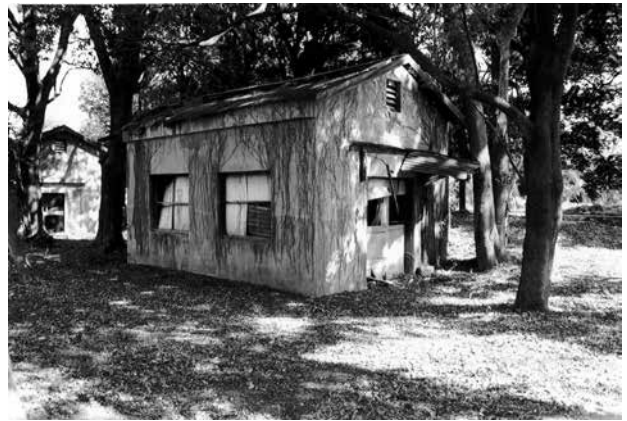
2 分配室北西、南西面外観
