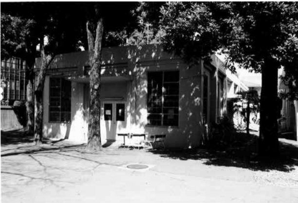
3 同1 屋根は陸屋根 ろく
