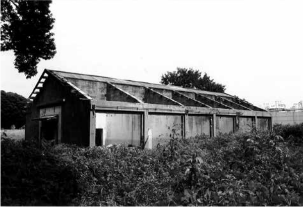
24 屋根と外壁を取り去った爆薬填実室 （平成 25 年 8 月 23 日撮影）
