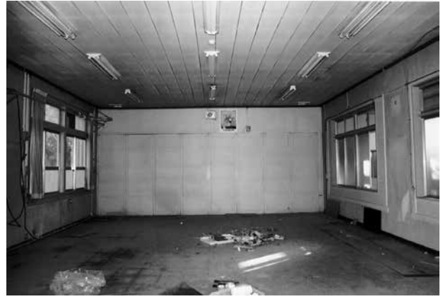
32 同 31 作業室の南西桁行方向を見る 間仕切りは後世の改造
