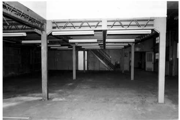
21 軽量鉄骨で2階の床を増築した
