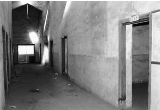
11 中廊下の両側に作業用の個室が並び、間仕切りは分厚いコンクリート製
