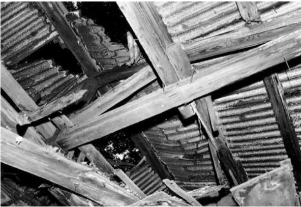
17 小屋組は木製トラスが約2m間隔に 架けられている
