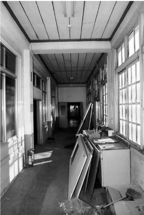
15 さらに進んで入口方向を見る 左手が作業の為の部屋
