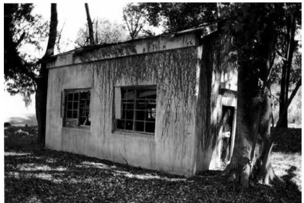
6 北西面 窓の戸は作り替えた痕が見られる
