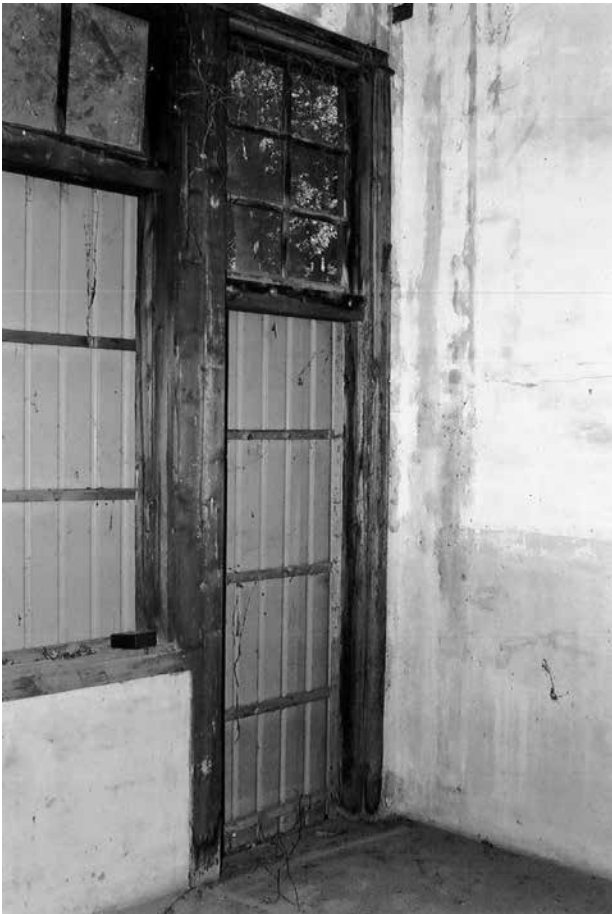
17 出入口周り 欄間は迂り出し
