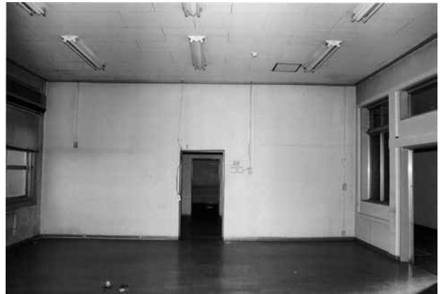
27 同 25 南西の桁行方向を見る 正面の壁はコンクリート造
