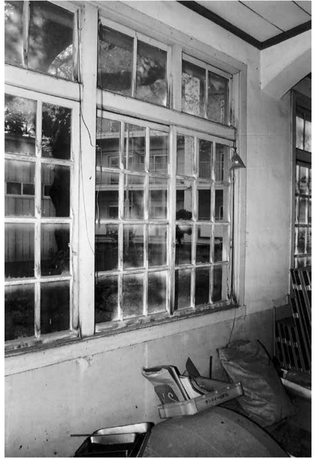
19 北西面の壁の木製の窓を廊下側から見る
