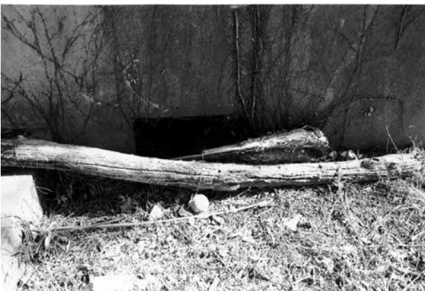
14 各面2カ所ずつ作られた床下通気口
