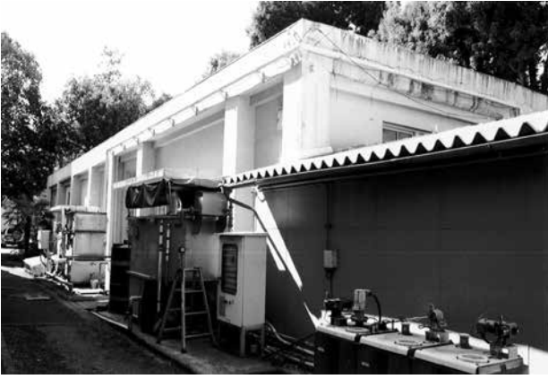
12 電気室を東隅からみる 手前は増築されたトイレ
