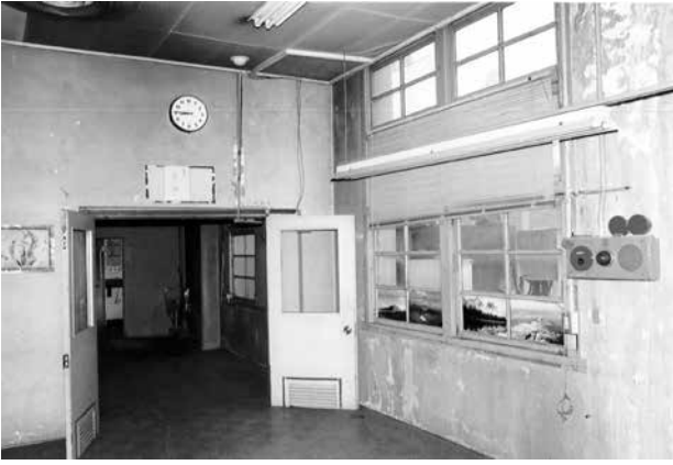
24 同 23 間仕切り部分の近景
