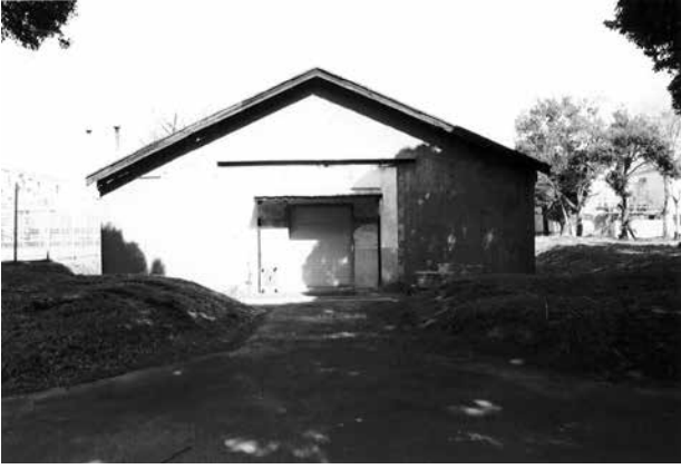
1 南西側正面全景 建物周囲には土塁の痕が確認できる
