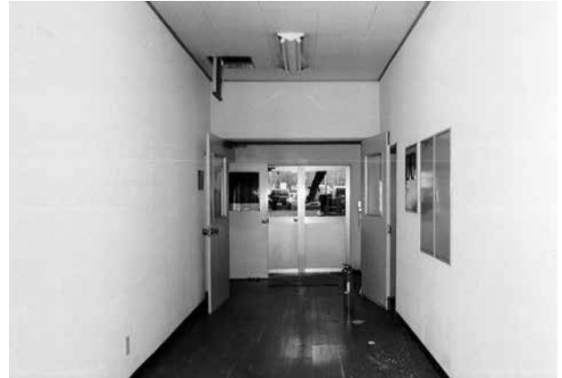
14 室内は片廊下になっている 廊下に立って入口方向をみたところ
