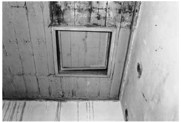
23 天井点検孔 天井板は杉の5分板張り
