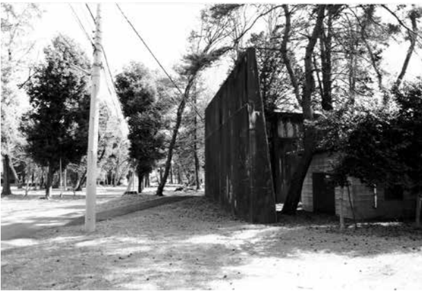
3 防爆壁の断面 柱底部の厚さは約 1m 程ある
