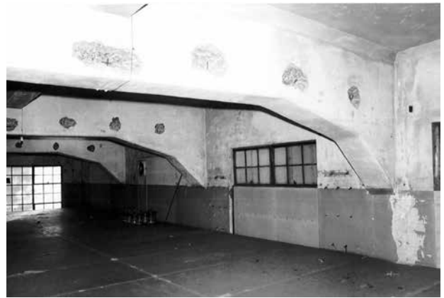
33 同 32 大梁の中央のスラブ下で 約 75 cmに達する
