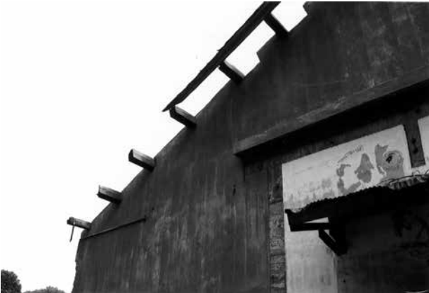
28 モヤの位置にあわせてコンクリート の壁が欠き込まれている
