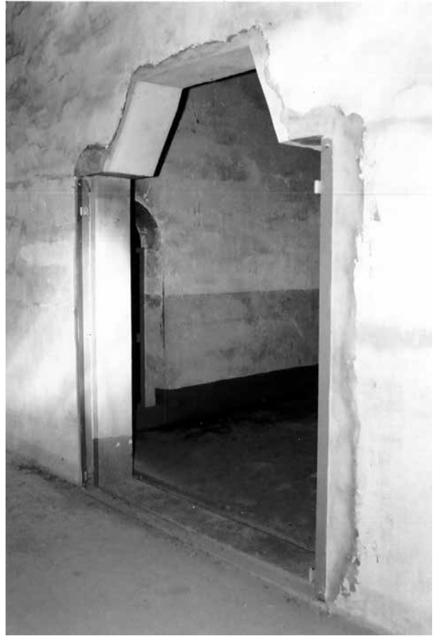
20 改造された作業室への出入口
