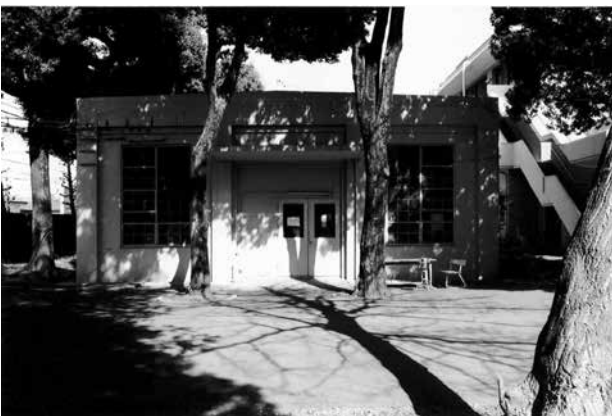
4 南西側正面 窓は金属製
