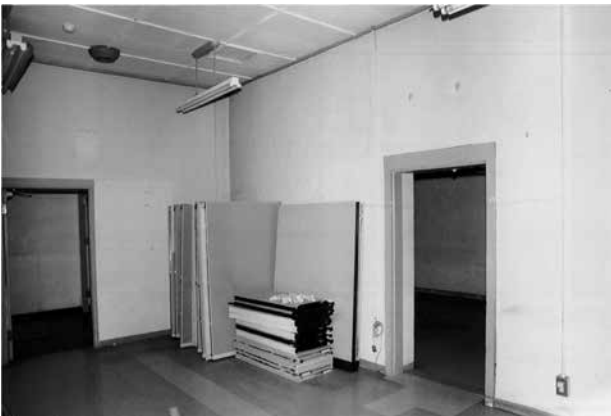
22 同 20 の部屋の廊下方向を見る
