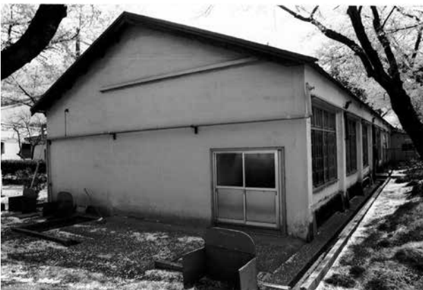
5 北側から見た建物全景 妻側には風除室 のような下屋が出ていた
