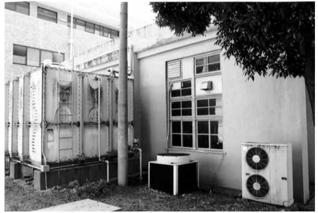
15 電気室北西妻側の外観
