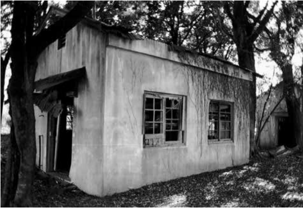
7 北方向から見た全景
