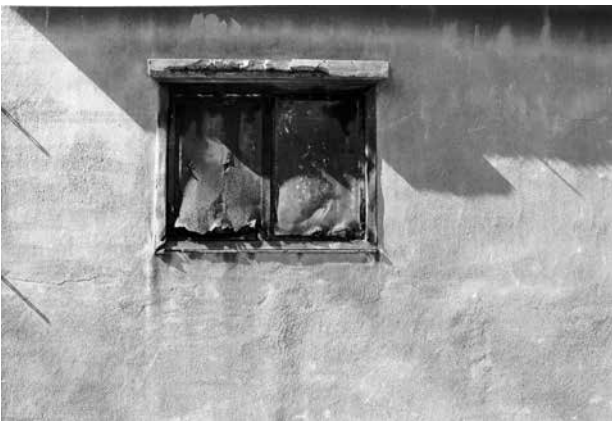
7 同6 南東面の窓近景
