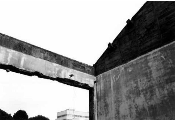
30 外壁上部の梁上の壁 厚みは約 30 cm
