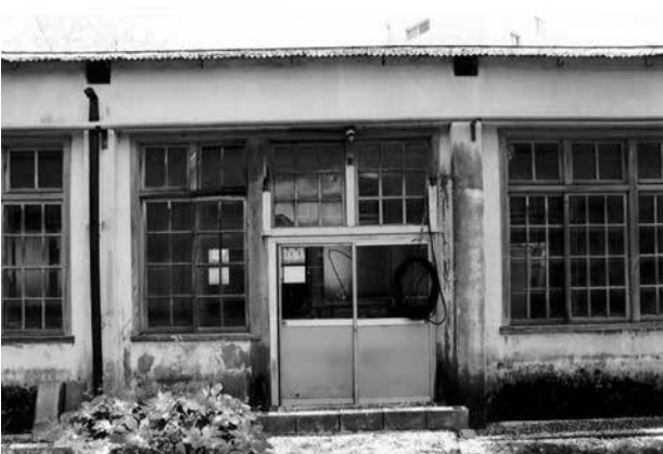
11 同10 壁面の丁度中央の柱間に作られた出入口
