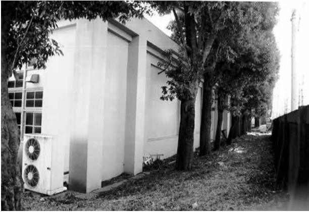
6 電気室を北隅より見る
