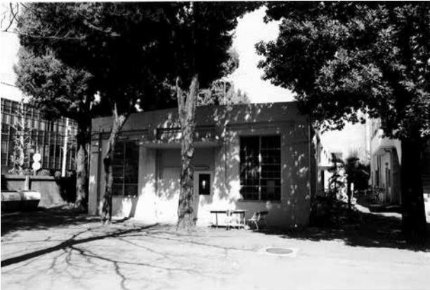
1 電気室南西正面外観
