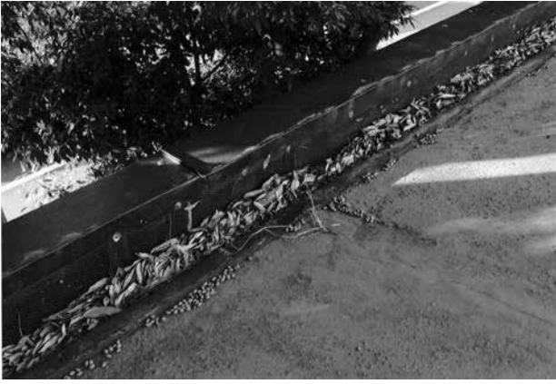
36 同 38 屋上周囲の立ち上がり
