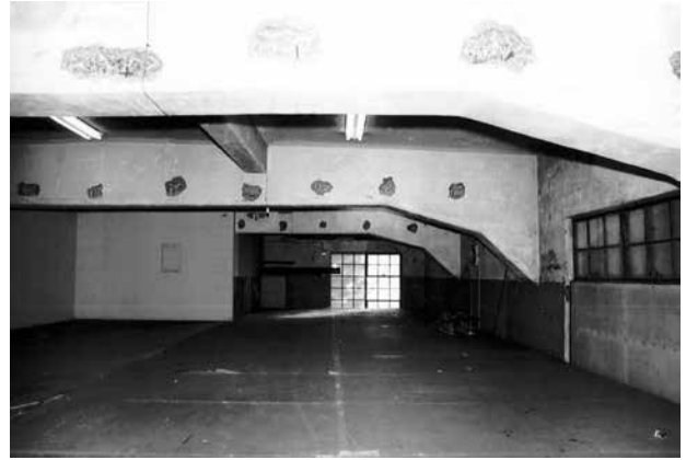
32 改造された2階 奥から入口方向を見る
