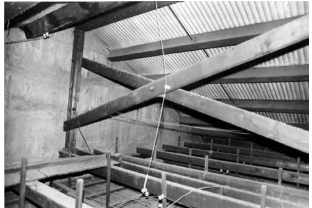
38 屋根は波形スレート葺きでタルキは使わずモヤで直接受けている
