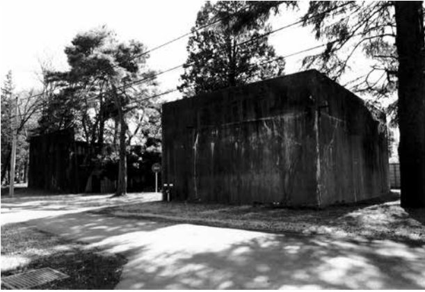
1 防爆壁全景 北方向から見る 鉄筋コンクリート製モルタル仕上げ
