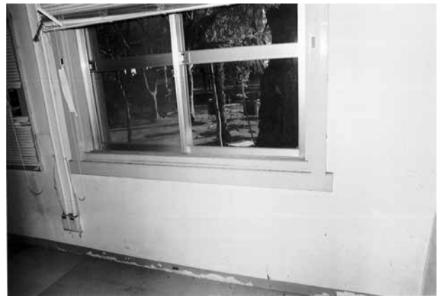
21 南西妻側の窓の一つ もとは木製の窓であった
