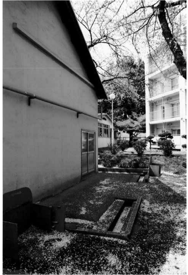
8 同左 反対側から見る かつての下屋の屋根の水切りが見える
