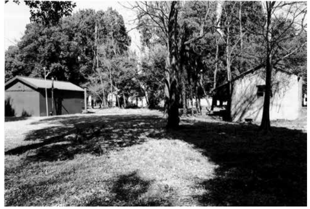
2 火薬倉庫はかつては土塁で囲われていた
