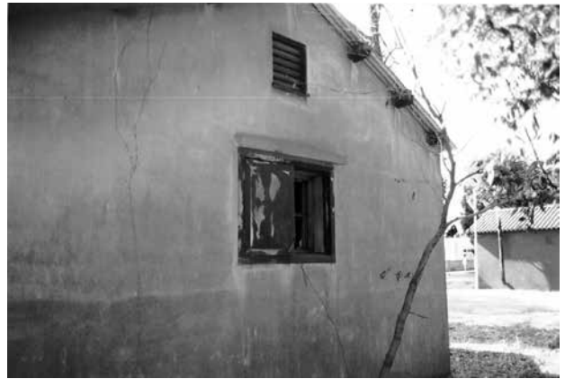
4 北東妻側の庇を伴う窓
