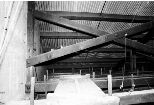
39 トラス相互の桁方向の振れ止め
