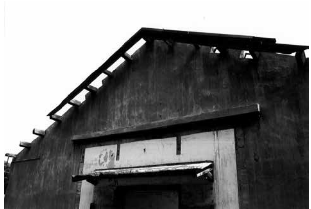
27 同左 モヤの脇に2箇所つつある隙間は 小屋裏通気孔
