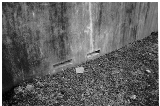
7 防爆壁の下部にあげられた 通気口と見られる穴
