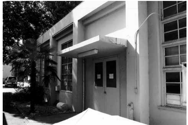
9 南東西側の手前出入口付近
