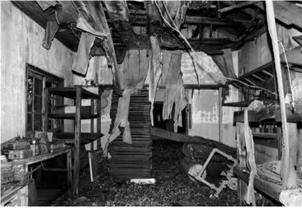
15 室内 南西妻側を見る 床はコンクリートの叩き土間
