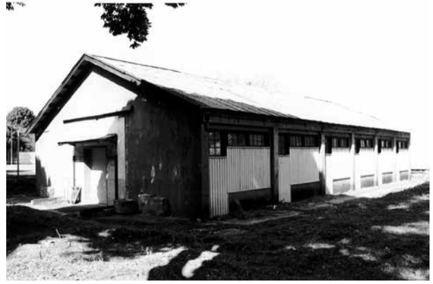
2 南から見た爆薬填実室全景
