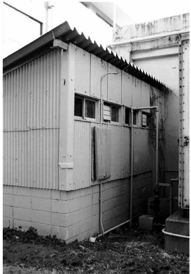
19 トイレ西面（北西面）
