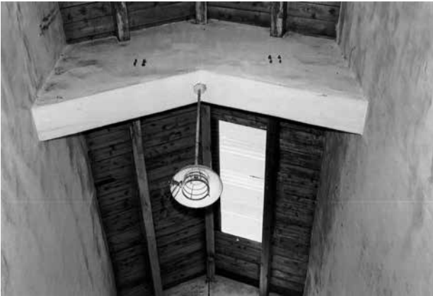
12 廊下の所々に採られた天窗
