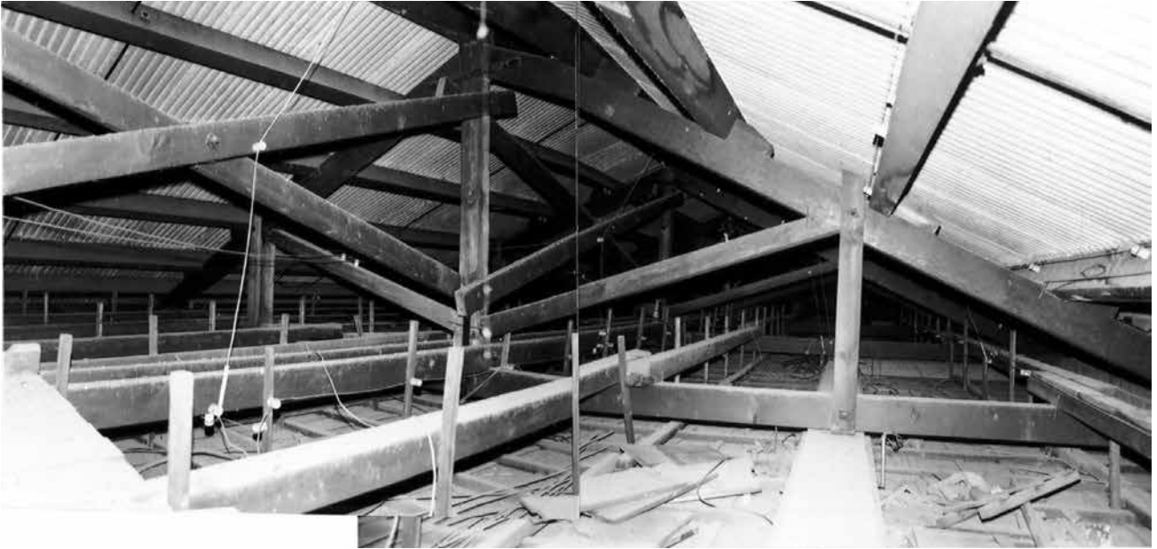
36 同 35 近景 トラス相互の間隔は約 4m で許容の限界に近い
