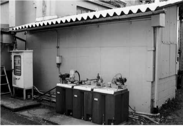
14 トイレ外観 もとは小さいトイレが作られていた
