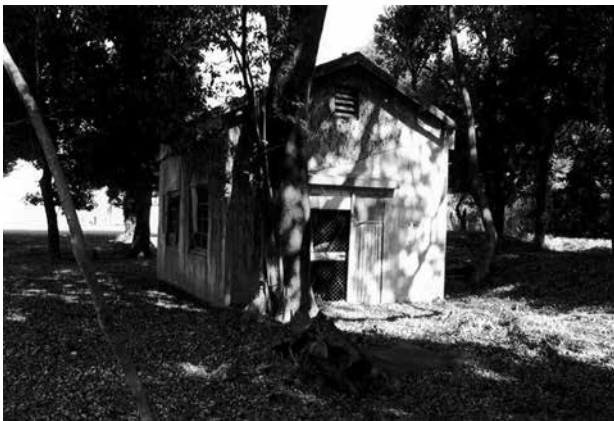
3 調査を行ったのは分配室の西側外観 手前のケヤキは実生の樹
