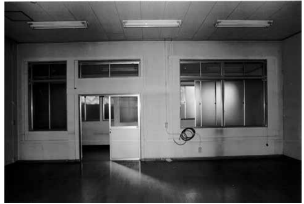
25 作業室内部 廊下境の壁もコンクリート造で 分厚い 当初の窓枠が残る
