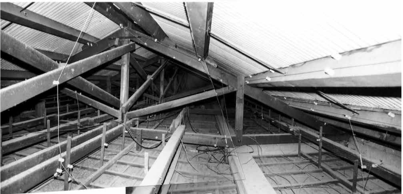
35 小屋組はキングポストラス構造 モヤには転び止めがつく
