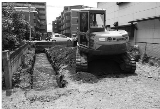
江川東遺跡第14地点試掘調査トレンチ1
