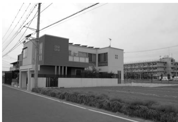
東中学校西遺跡第31地点近景
