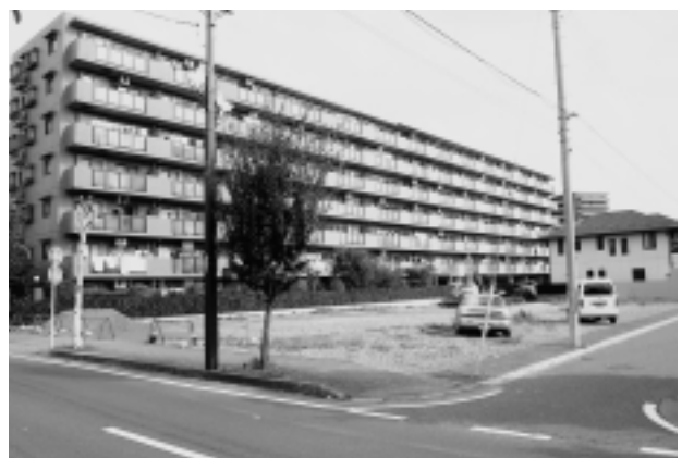
本村遺跡第114地点調査区近景
