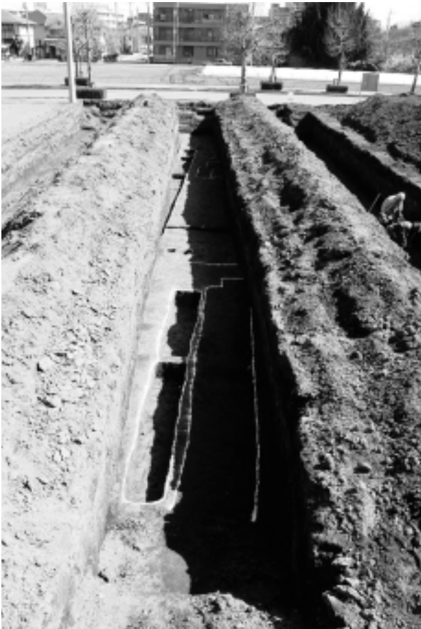
大井氏館跡遺跡第20地点トレンチ
