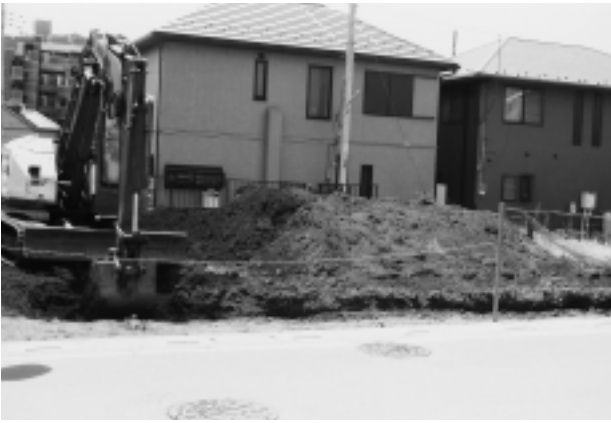
本村遺跡第113地点調査区近景
