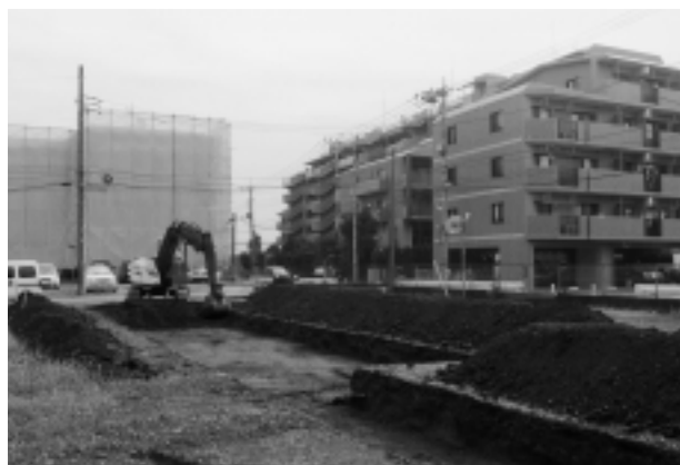
江川東遺跡第10地点調査区近景
