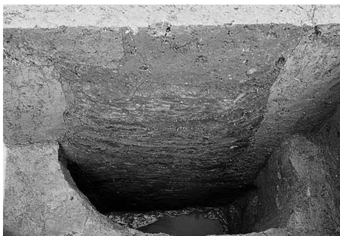
SE33 断面(西から)
