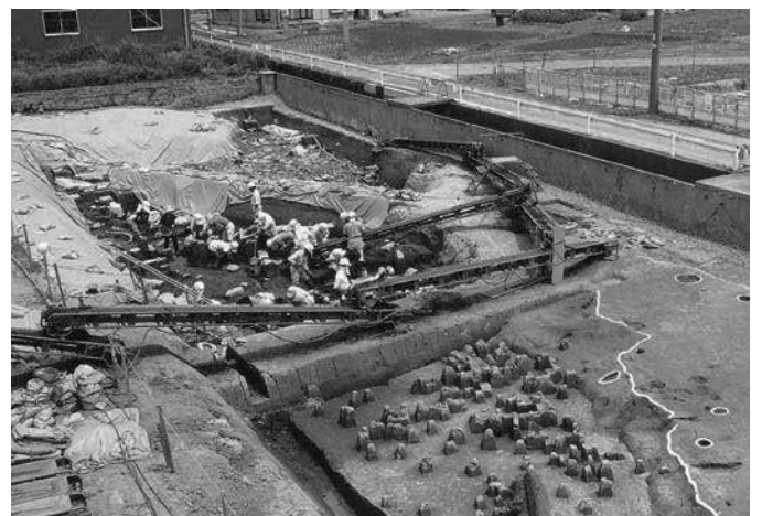
流路1 作業風景 南から
