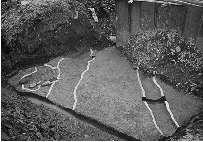
SD1010・1014、SK1013 完掘 南東から
