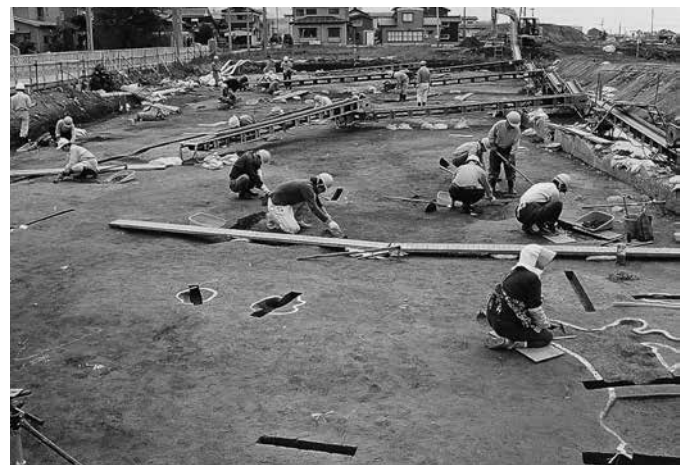
作業風景 東から
