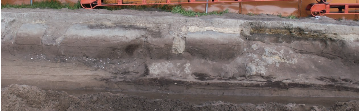
08B 区東壁土層断面（西より）
