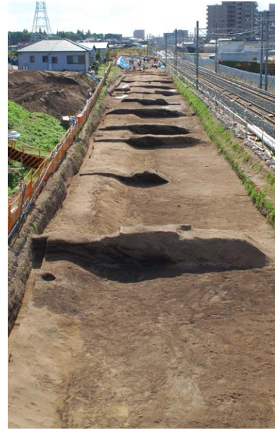
08Aa 区 G 層完掘削状況 (北より)
