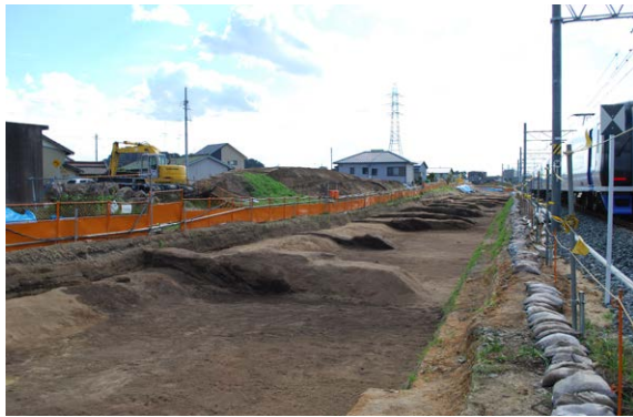
08Aa 区 G 層完掘削状況 (北西より)
