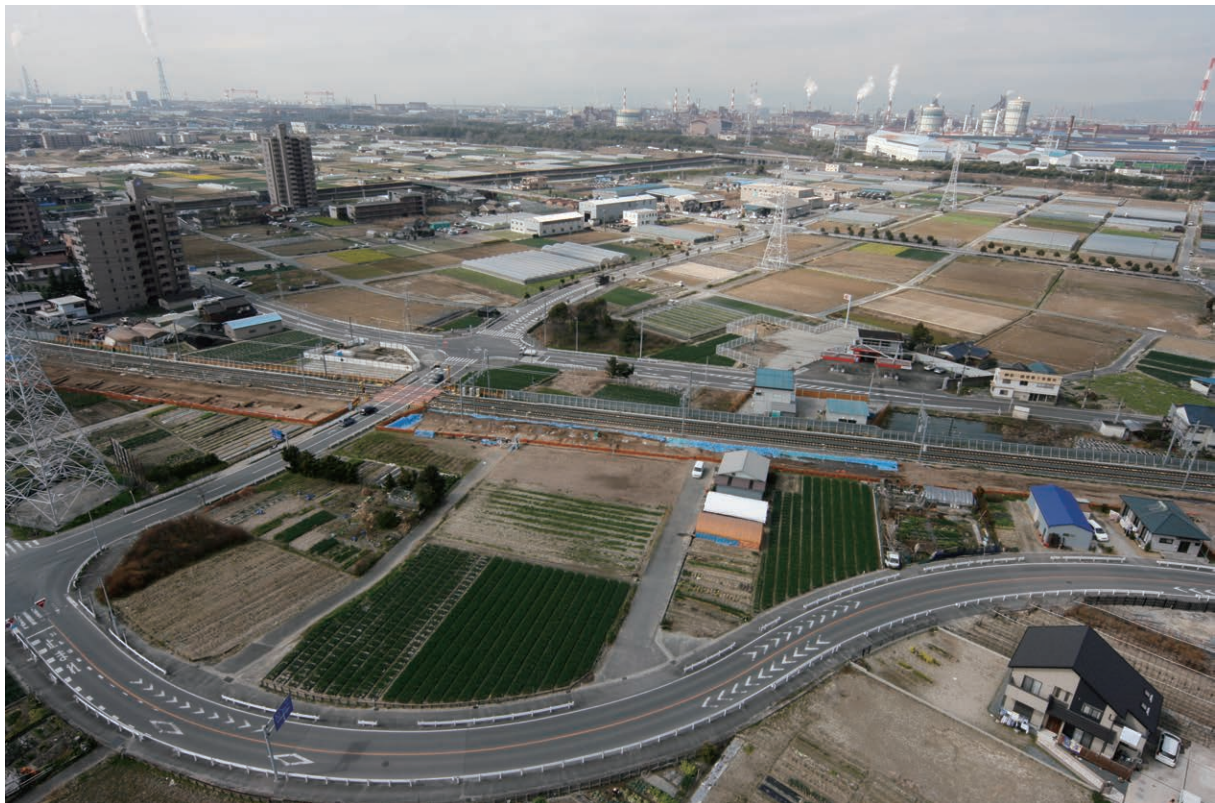
調査区近景（東より）
