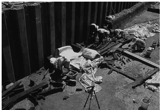
SX119 作業風景 (北東から)
