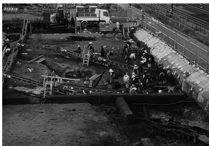
流路調査風景 (東から)
