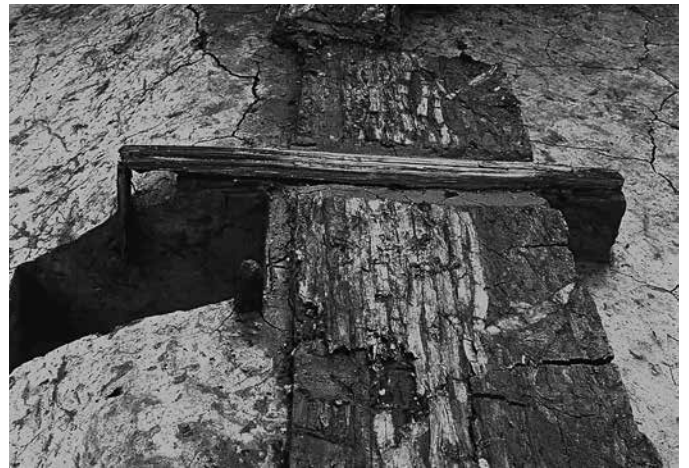
SX119 足場板下の枕木 (西から、図版 71 3-3')
