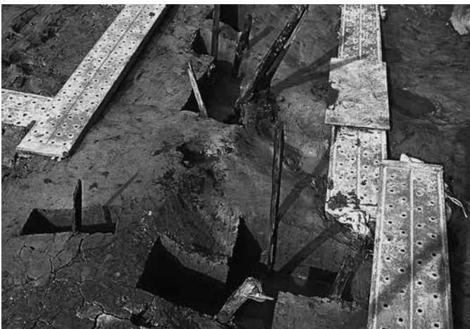
SX119 に打ち込まれた杭 (西から、図版 72 2-2' 付近、SD109 沿いに多数打ち込まれる)
