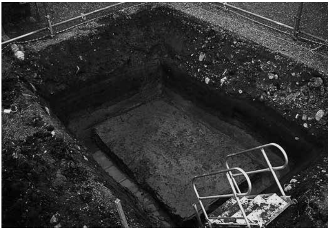
R4-1 区 完掘 (北東から)
