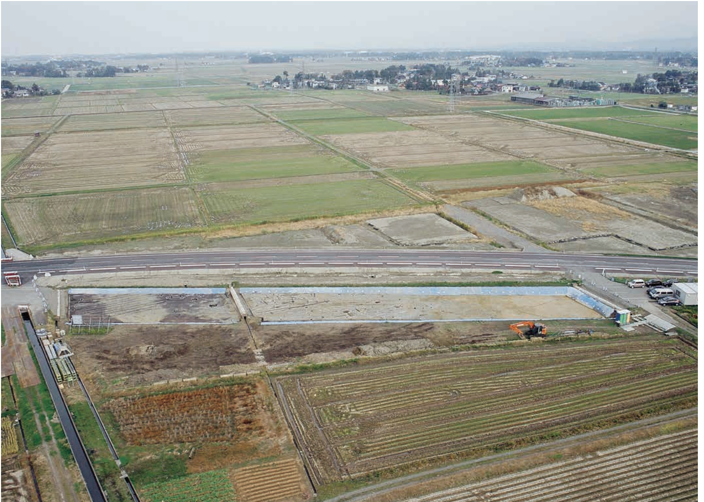
調査区全景（上空南西から）
