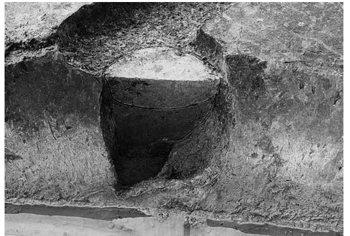
SB17 P2250 断面 (北東から)
