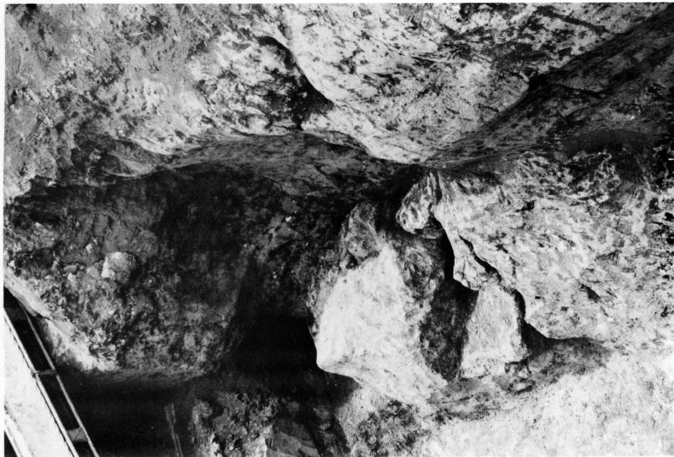
2. 隧道側壁陥没状態 (西から)
