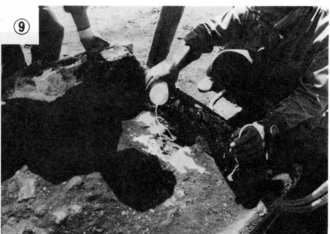
⑨ 裏土の表面にエポキシ樹脂エマルジョンを塗って固める。 薬剤：エマルジョン（主剤・プリゾールL-601、硬化剤・プリゾールL-602）主剤対硬化剤＝3対1、適宜水でうすめる。
