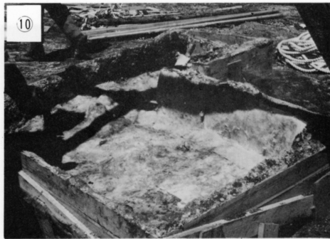
10 裏土の表面にポリマールをしみ込ませたグラスファイバーマットをはり、さらに固め、安定させる。 薬剤：ポリマール（ポリエステル樹脂）触媒にパーメック（ベンゾールパーオキシド）を使う。主剤対触媒＝100対1
