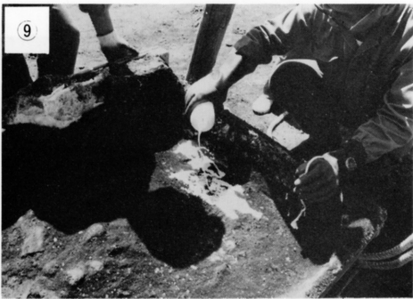
9 裏土の表面にエポキシ樹脂エマルジョンを塗って固める。 薬剤：エマルジョン（主剤・プリゾールL-601、硬化剤・プリゾールL-602）主剤対硬化剤＝3対1、適宜水でうすめる。
