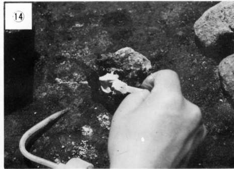
動く石はエポキシ系の接着剤で固定し、ひびがはいて土が動く場合は、エポキシ樹脂エマルジョンの原液を流し込んだり、土と練ったものをつめておく。 薬剤：エポキシ系接着剤、エポキシ樹脂エマルジョン
