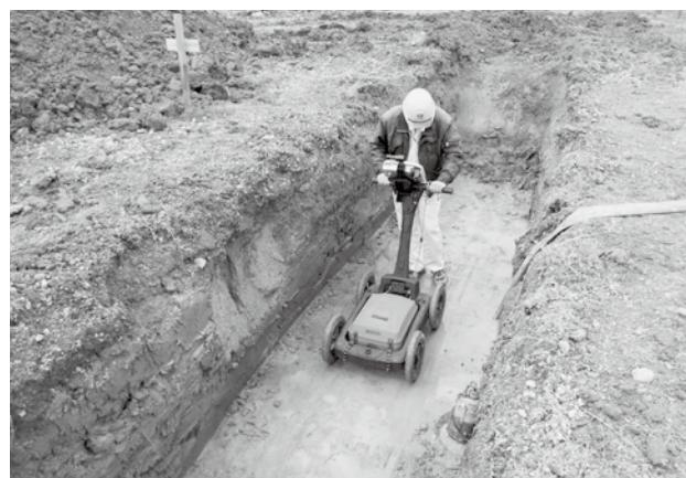
図37 地中レーダー探査状況
