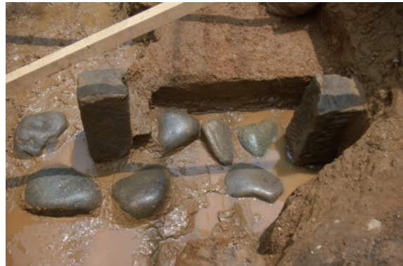
地盤の悪い場所に工夫して建てた建物の基礎
