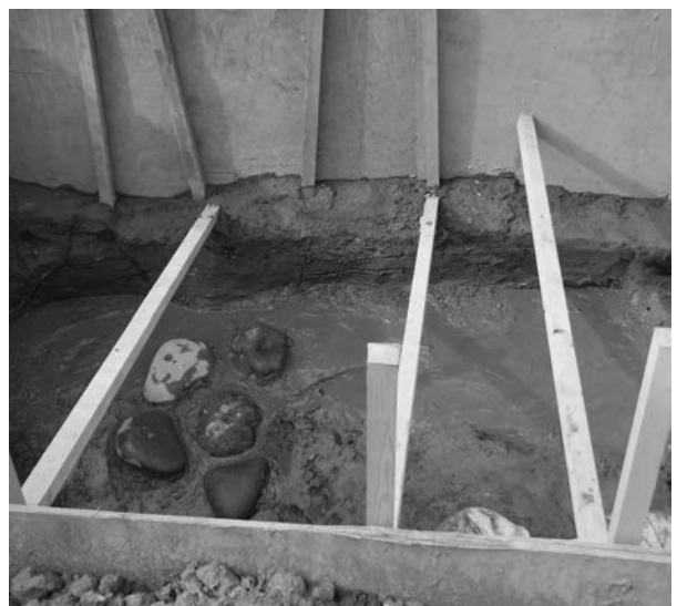
F区整地層土層断面
