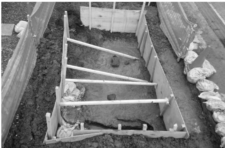
調査 F 区全景 ( 東側 から )
