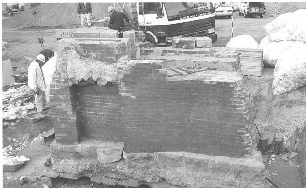
fig.11 煉瓦下水道移設工事
