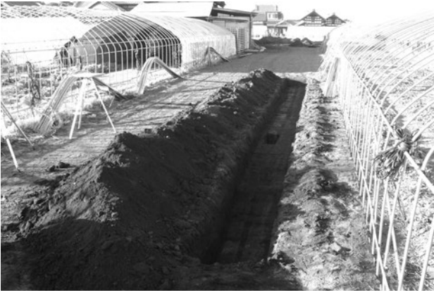
32 宿ノ内遺跡第4次, 西中根遺跡第4次調査区
