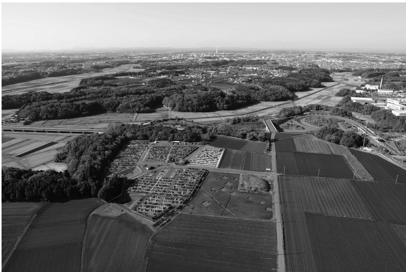
2 全景(南東から)
