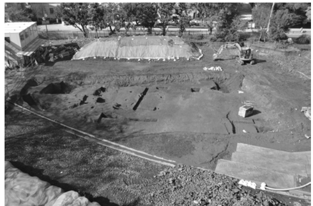
写真 35 3区 第1面全景 (東から)
