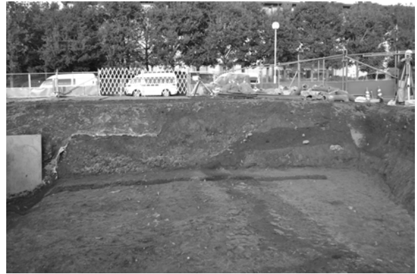
写真8 A地点土層堆積状況（南から）
