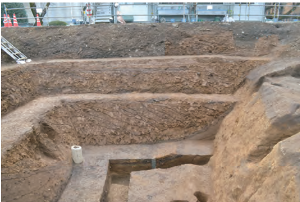
4区 南壁断面（北から）
