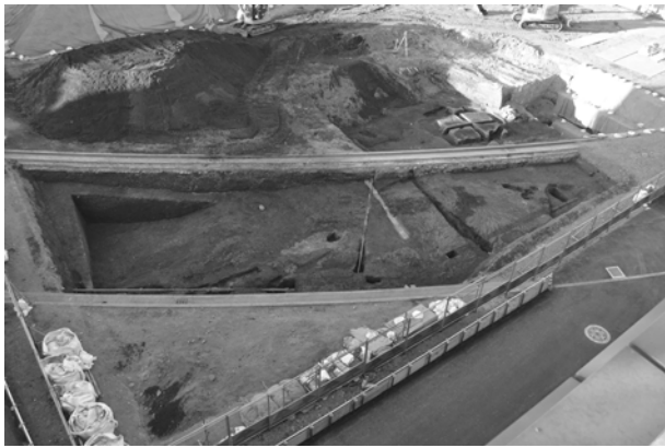
写真25 2-B区 第4-3面全景 (南東から)
