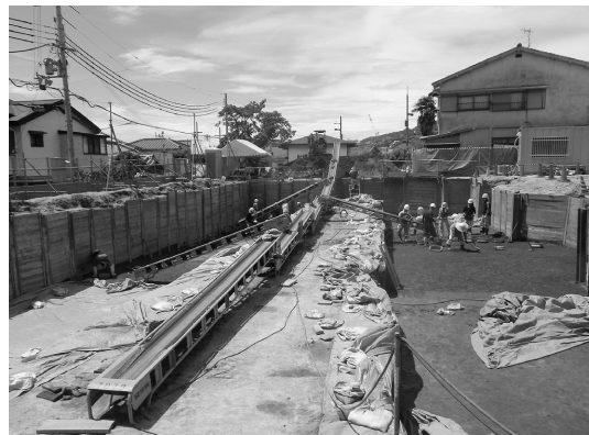
写真2 2～4区ベルトコンベア使用状況
