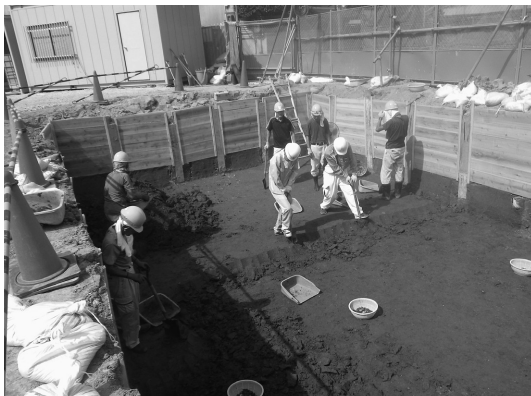
写真1 1区人力掘削風景
