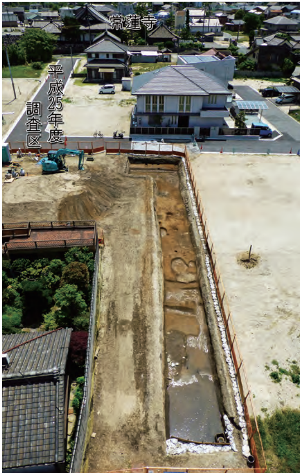
1 地点完掘状況
