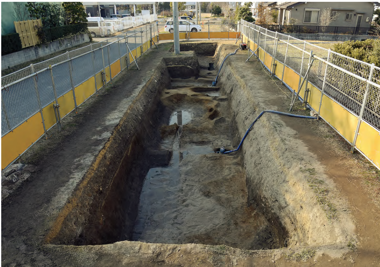
1 7地点全景 (東から)
