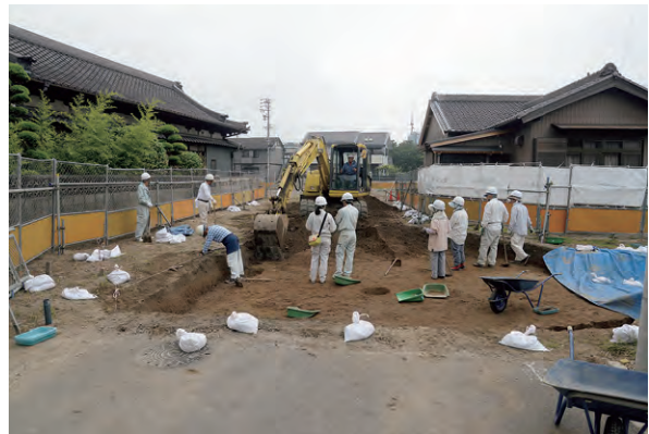
写真3 1地点機械掘削状況
