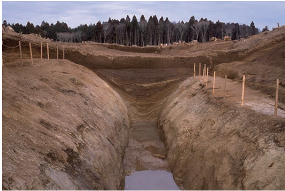
堀跡に堆積した土砂の様子
