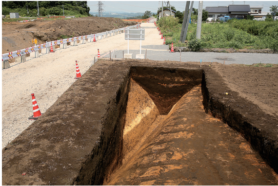
第1号堀跡完掘状況（南から）
