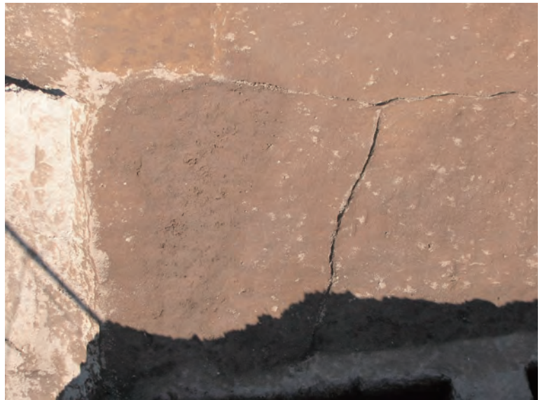
第11号竖穴建物跡（南から）
