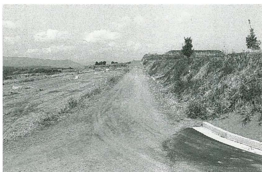
調査地点近景 （1トレンチを南側より、カメラ2トレンチ直上）
