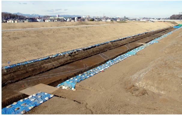
1 3区水田跡全景
