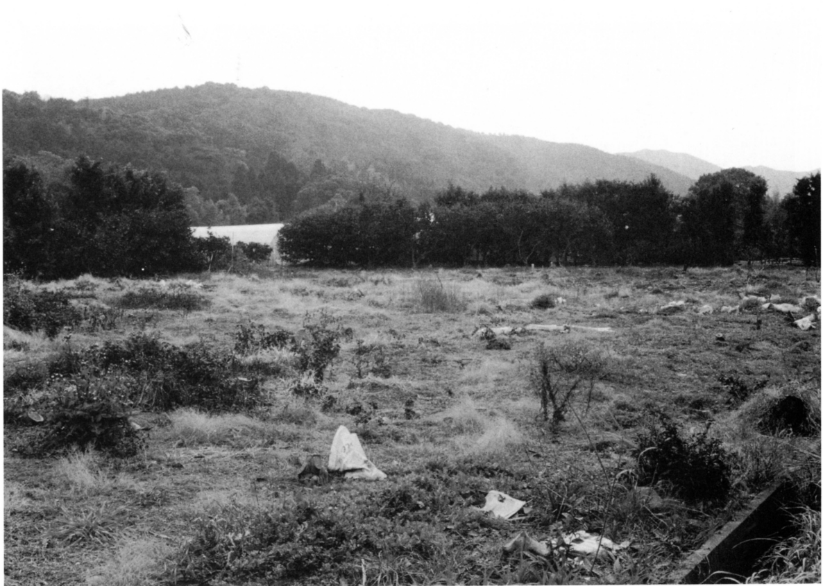
変電所建設部全景
